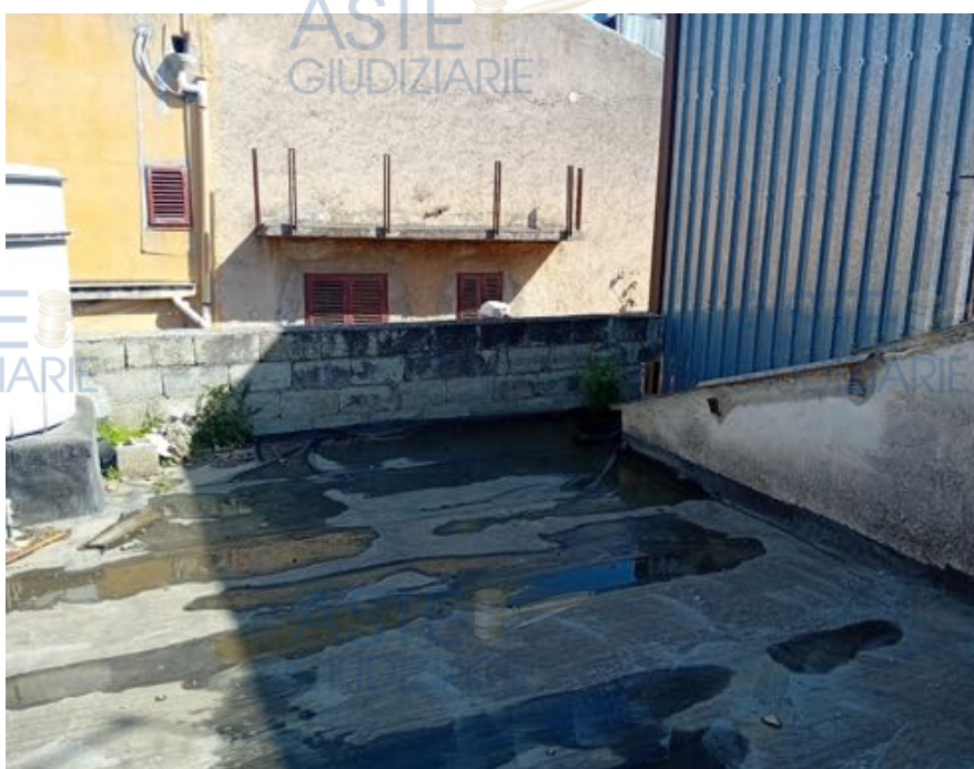
Foto interni piano primo; lastrico solare piano secondo
