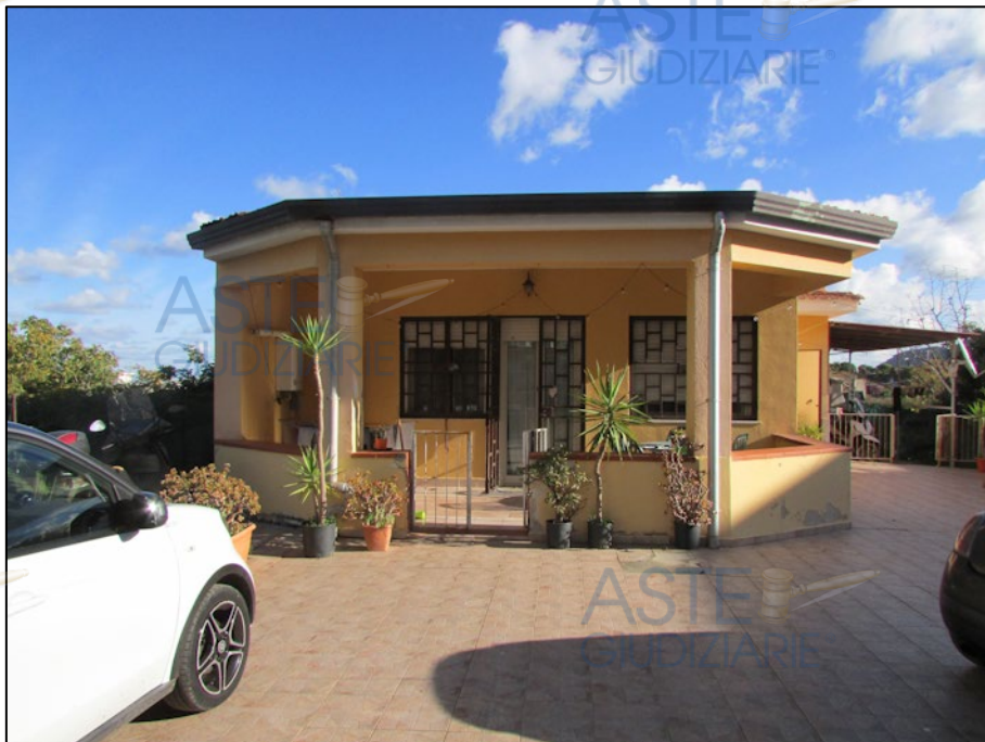
Figura 6: Ripresa del prospetto principale sud-ovest dell'immobile pignorato
