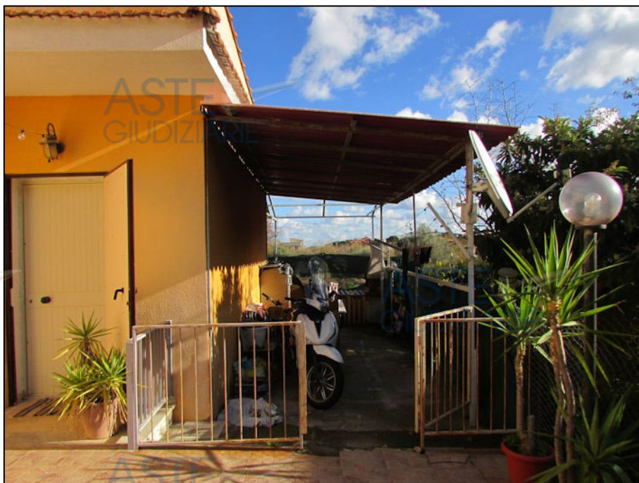
Figura 7: Particolare del prospetto sud-est dell'immobile pignorato
