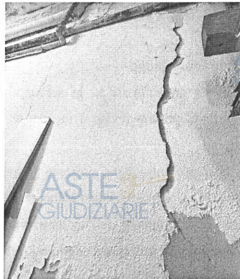
Fig. 7 Parete perimetrale a confine con terrapieno.
