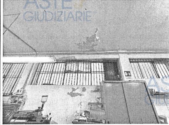
Fig. 9 Parete perimetrale a confine con rampa carrabile.
