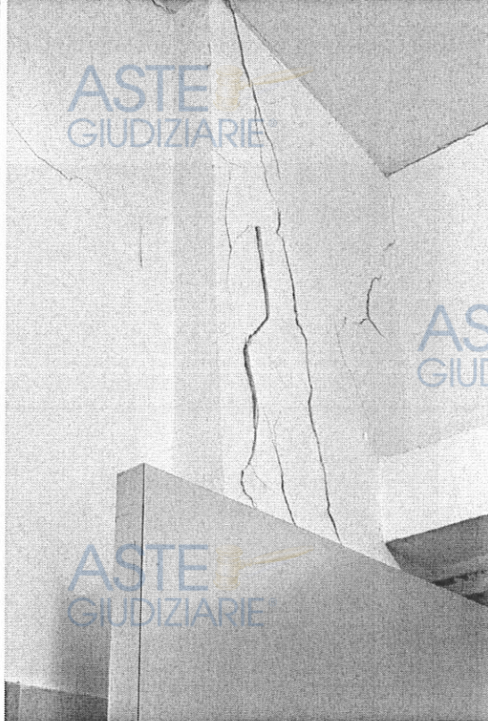
Fig. 11 Pilastro all'interno del wc.
