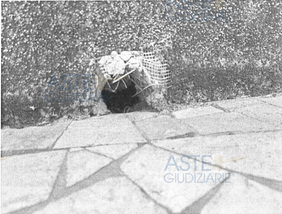
Fig. 18. Originario punto di raccolta delle acque meteoriche del terrazzo d'ingresso condominiale, la cui posizione corrisponde alla tubazione della fig. 17.
