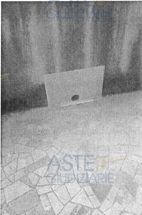
Fig. 19 . Nuovo intervento sul chiusino di cui alla foto n.18.
