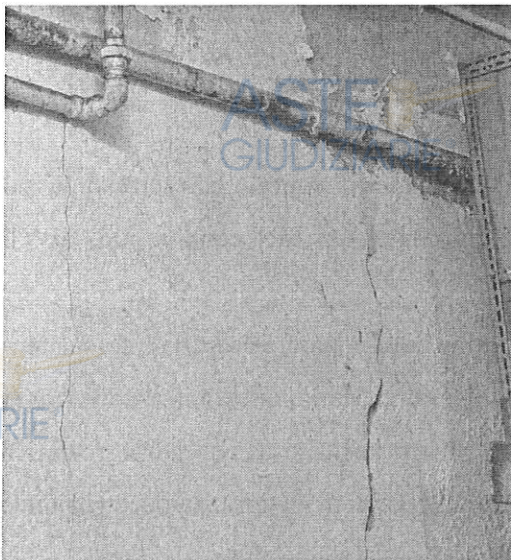
Fig. 6 Parete perimetrale a confine con terrapieno.
