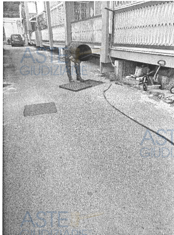
Fig. 15 Pozzetto d'ispezione.
