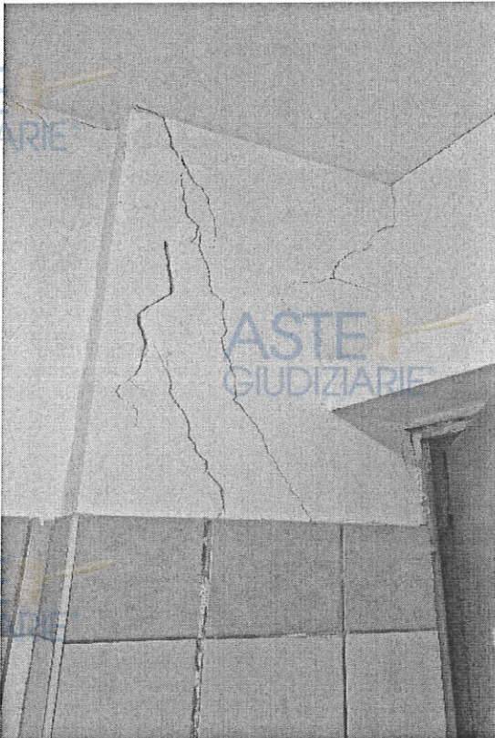
Fig. 10 Pilastro all'interno del wc.
