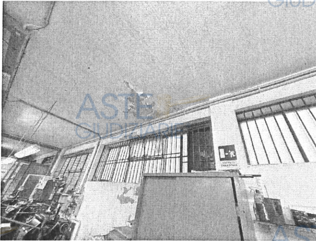
Fig. 23. Porzione di soffitto e parete perimetrale confinante con la corsia carrabile
