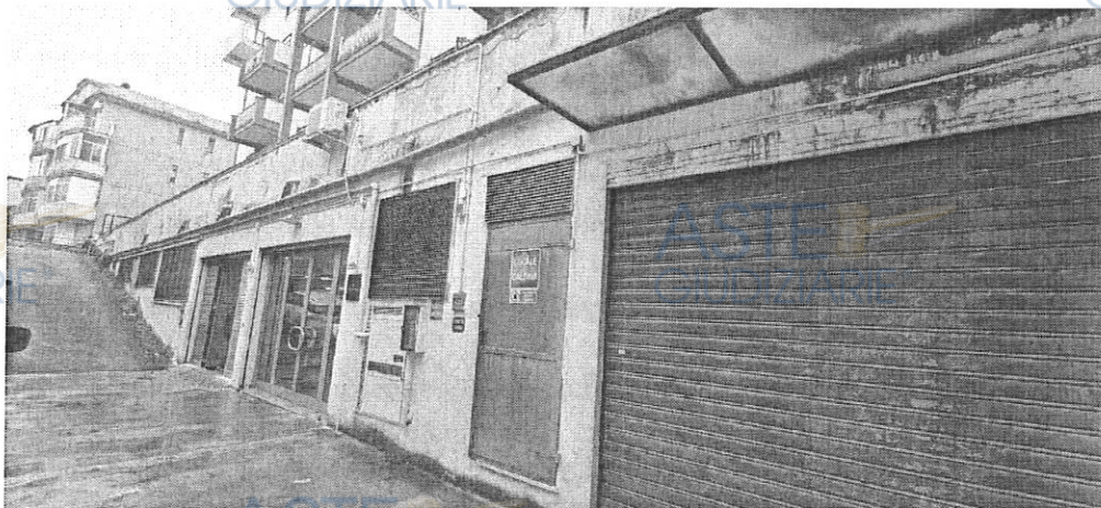
Figura 3 – Parete esterna con accesso ai locali
