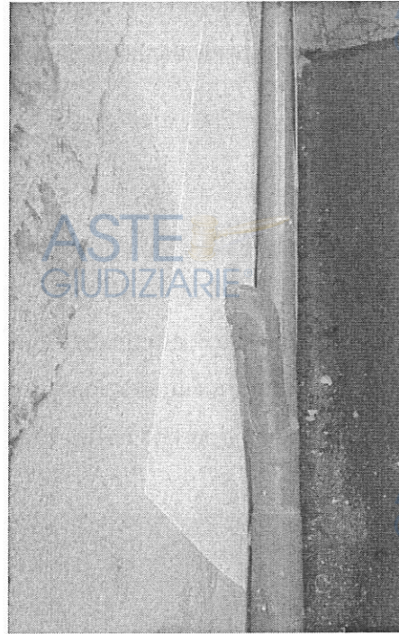
Fig. 20 . Nuova tubazione di cui alla foto n.18.
