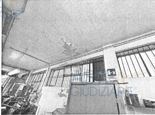
Fig. 8 Parete perimetrale a confine con rampa carrabile.
