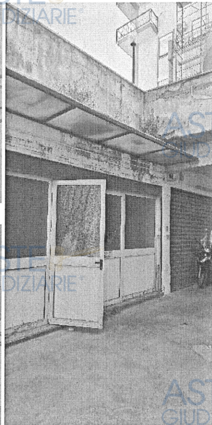
Fig. 8 - Ingresso del lotto 2 al piano S1
