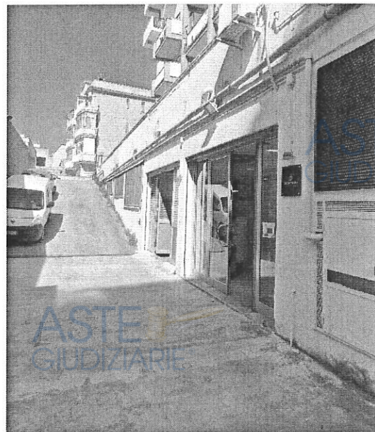
Fig. 5 - Vista dei due portoni di ingresso al lotto 3.
