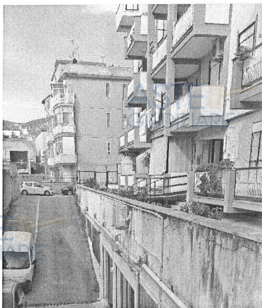
Fig. 4 - Rampa di accesso al lotto 3.
