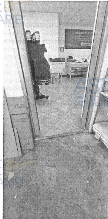
Fig. 15 Zona di passaggio tra gli uffici ed il locale lavorazione.
