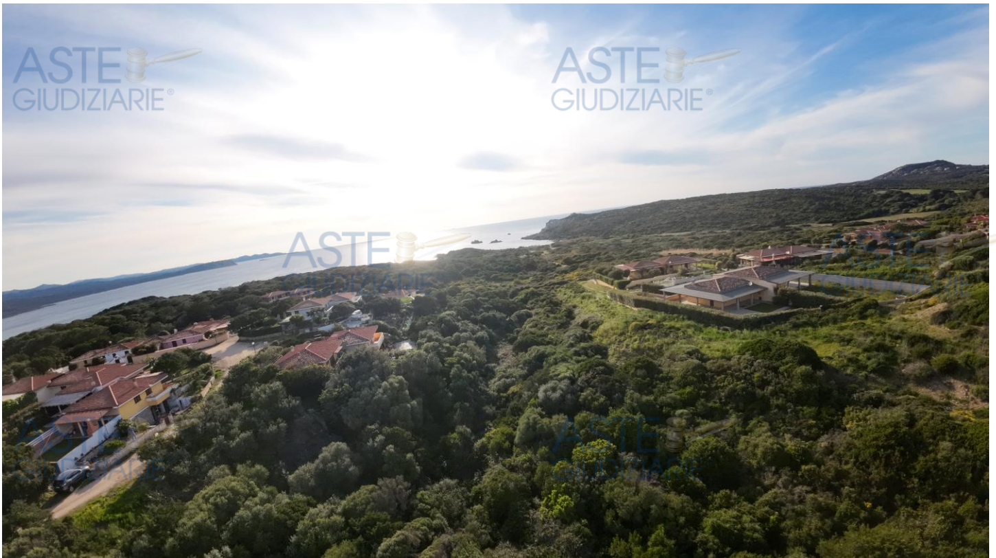
Figura 4 – Vista area del complesso realizzata attraverso l’ausilio di Drone fotografico
