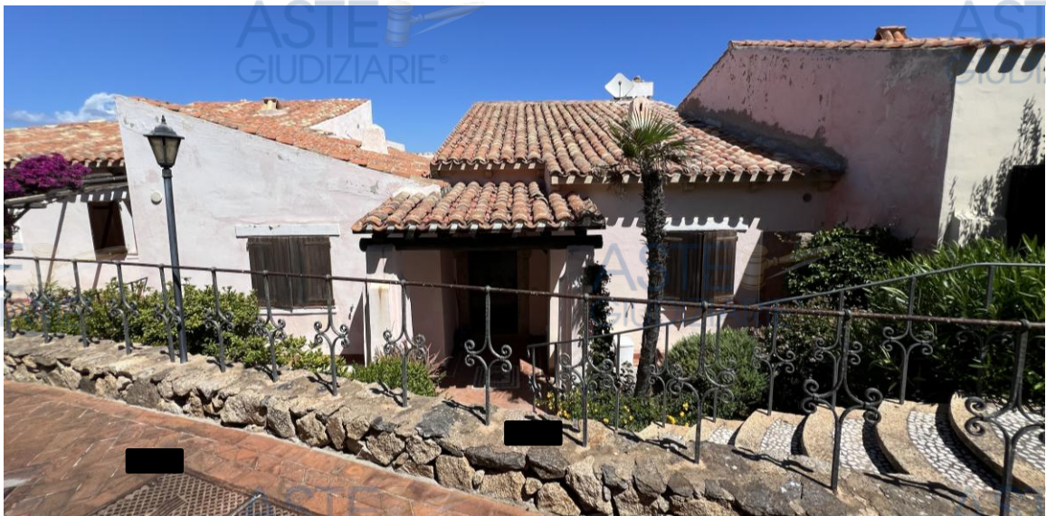
Figura 4 – vista frontale del bene
