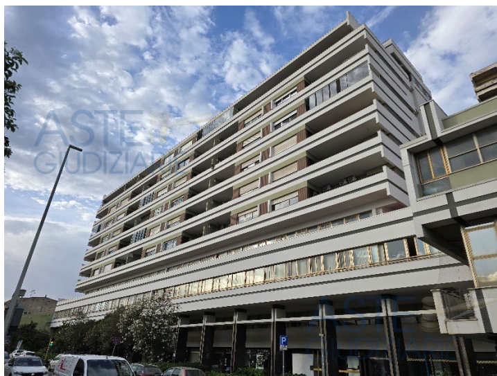
Facciata fabbricato B fronte via Cagliari
