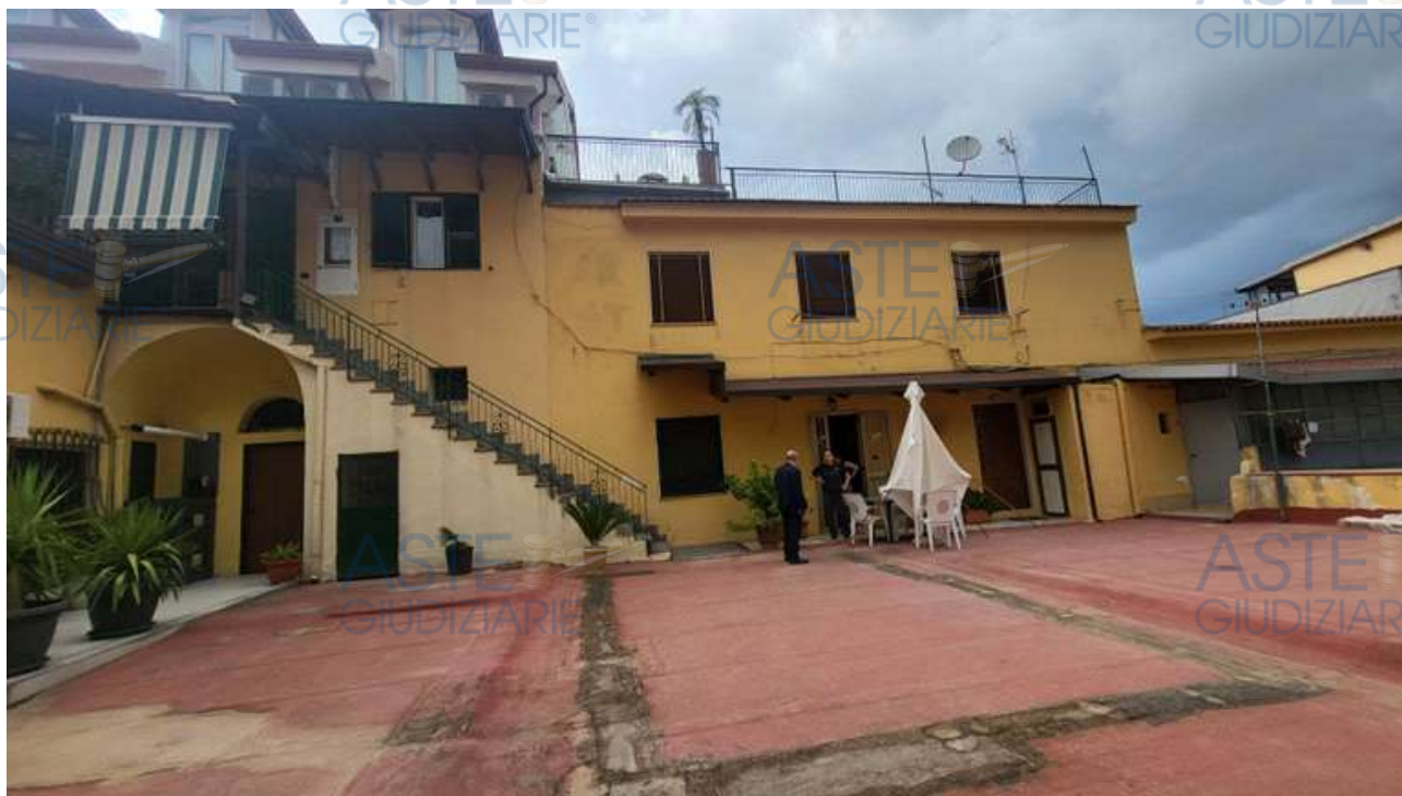
Vista dall'esterno della p.lla 20 sub. 20 – Fronte Sud
