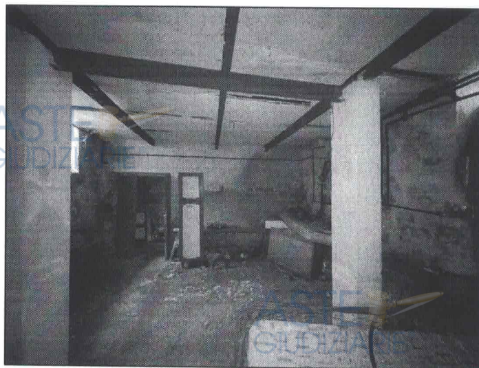
-Cantina al piano interrato-
