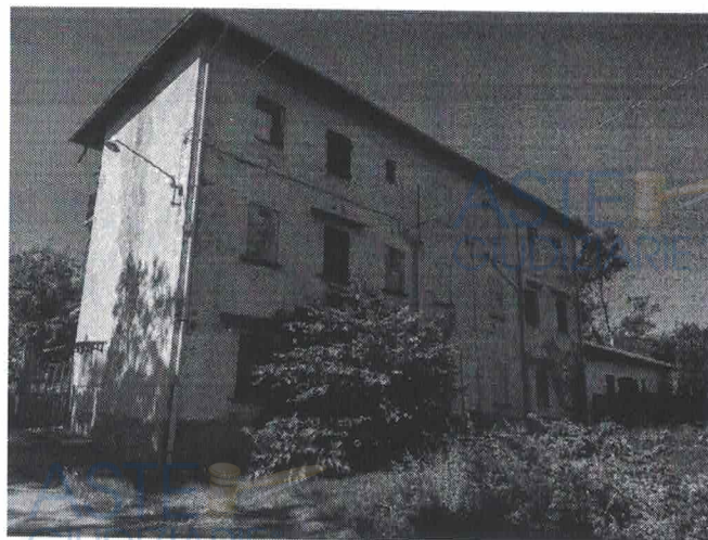
Fronte nord ed est
