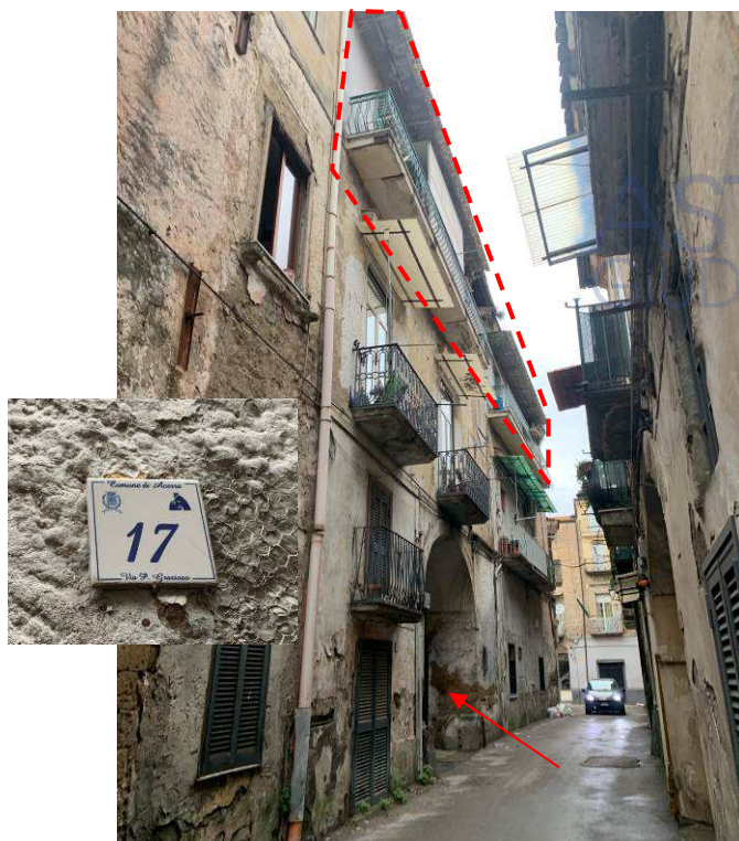
Prospetto principale dalla Via Pasquale Grazioso
