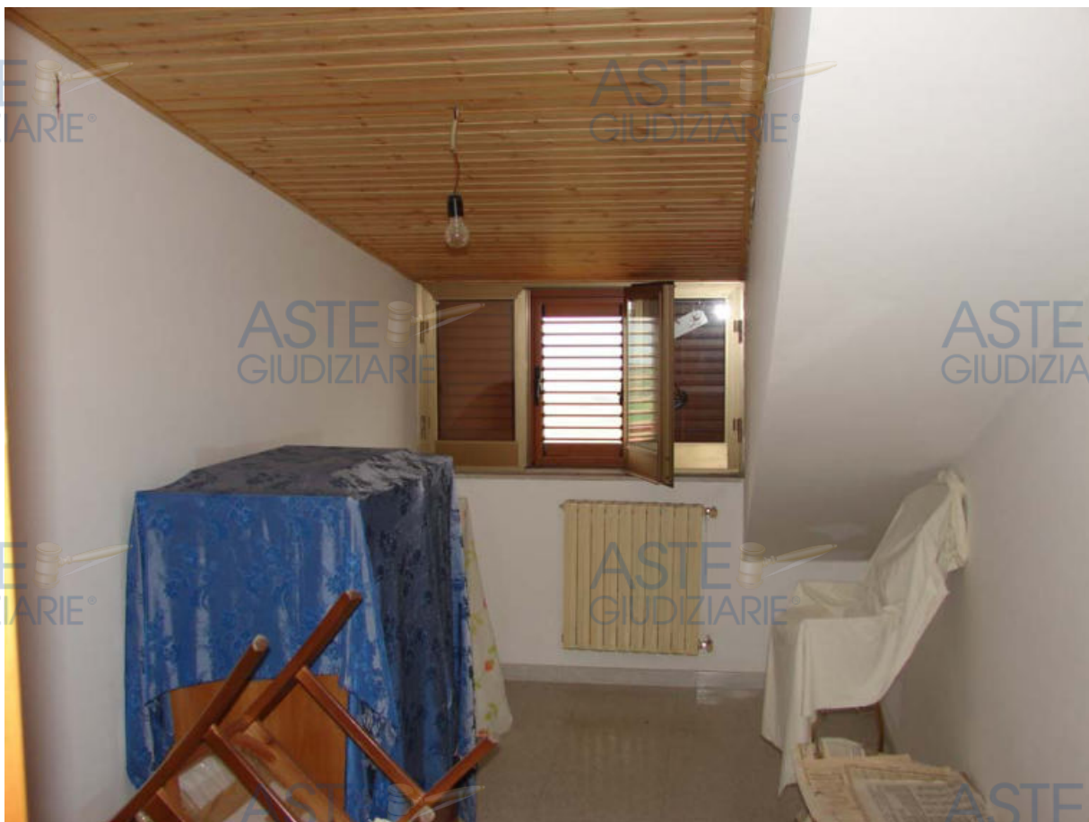
Foto n. 11 – Vista della camera 1 al terzo piano
