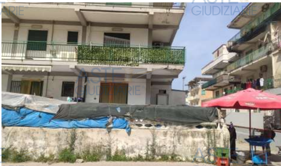
ALTRA VISTA DEL FABBRICATO
