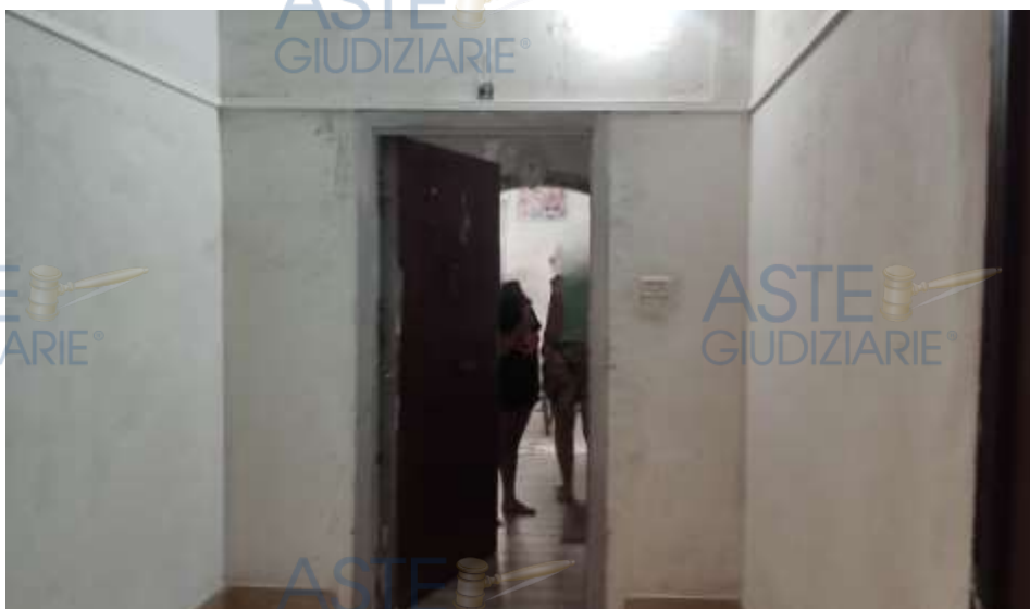
VISTA DELL'INGRESSO ALL'UNITÀ DAL VANO SCALA A
