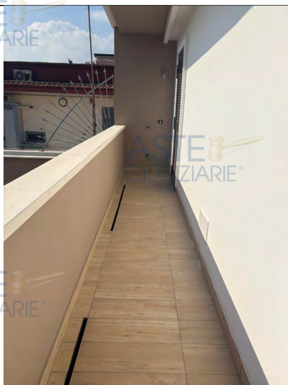
Fotografia n. 5 _ Balcone al primo piano
