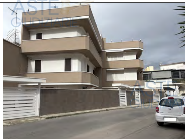
Fotografia n. 2 _ Prospetto su via Napoli, vista sud/nord
