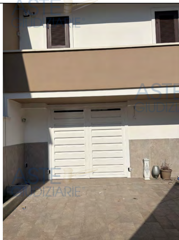
Fotografia n. 4 _ Ingresso al box auto
