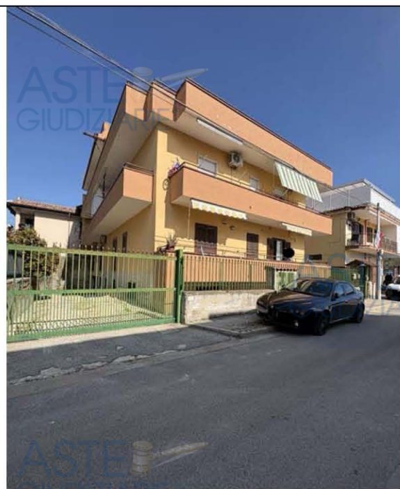
Fotografia n. 2 _ Prospetto nord/ovest del fabbricato
