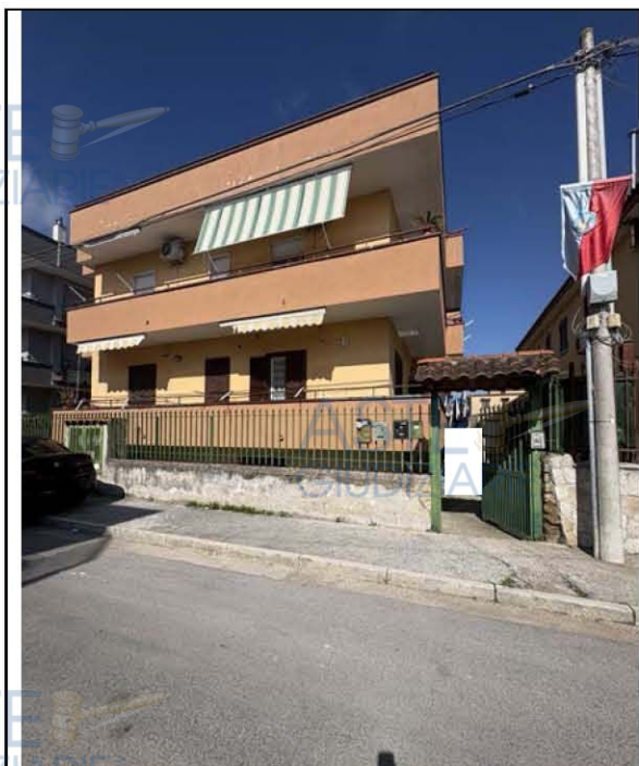
Fotografia n. 1 _ Prospetto ovest del fabbricato su via Dalla Chiesa
