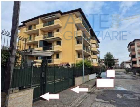
Figura 3 facciata sud/est del fabbricato con accesso pedonale e carrabile al cortile comune del Condominio Parco Arcobaleno 3 – Edificio A/13 in Orta di Atella
