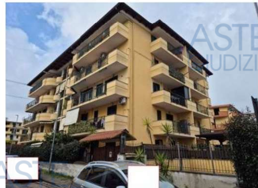
Figura 4 facciata nord/est del fabbricato del Condominio Parco Arcobaleno 3 – Edificio A/13 in Orta di Atella
