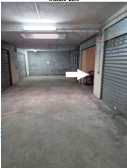
Figura 26 accesso al box auto al piano interrato
