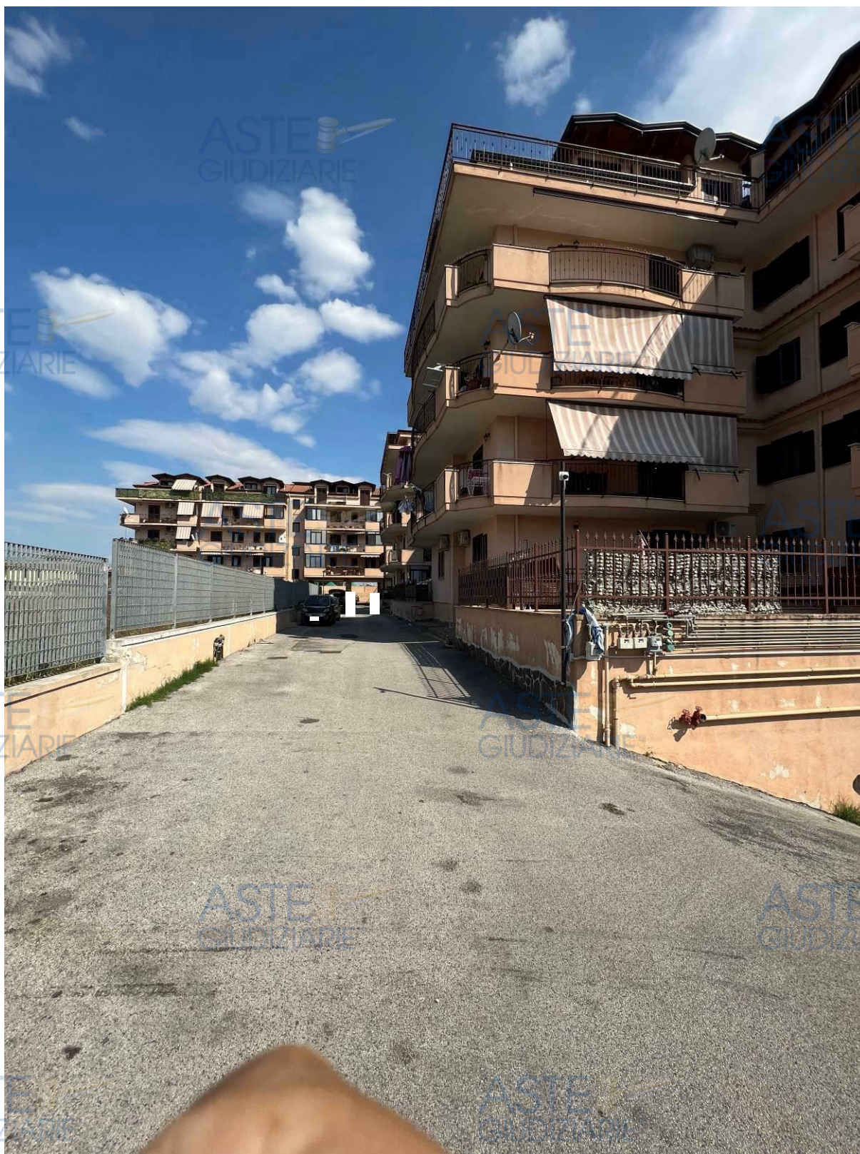
Foto Viale di accesso
