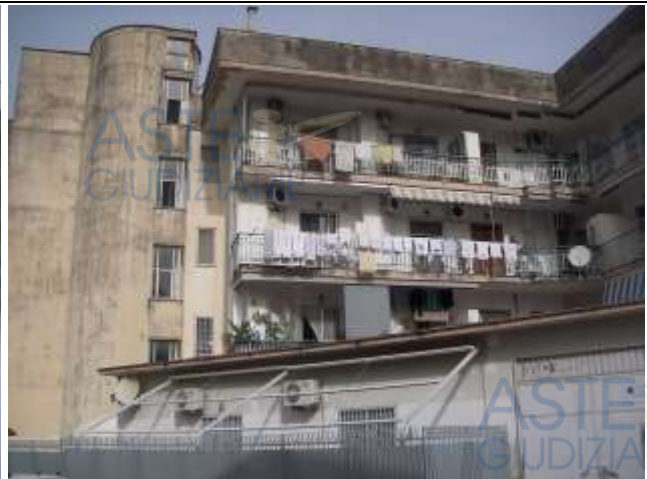
(foto n. 2: Vista fabbricato)
