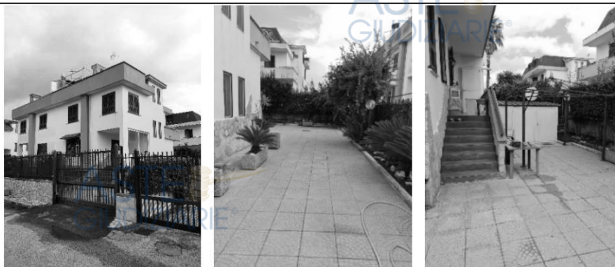
Foto 1/2/3 – Vista accesso pedonale e carrabile – vista cortile interno – vista cortile posteriore
