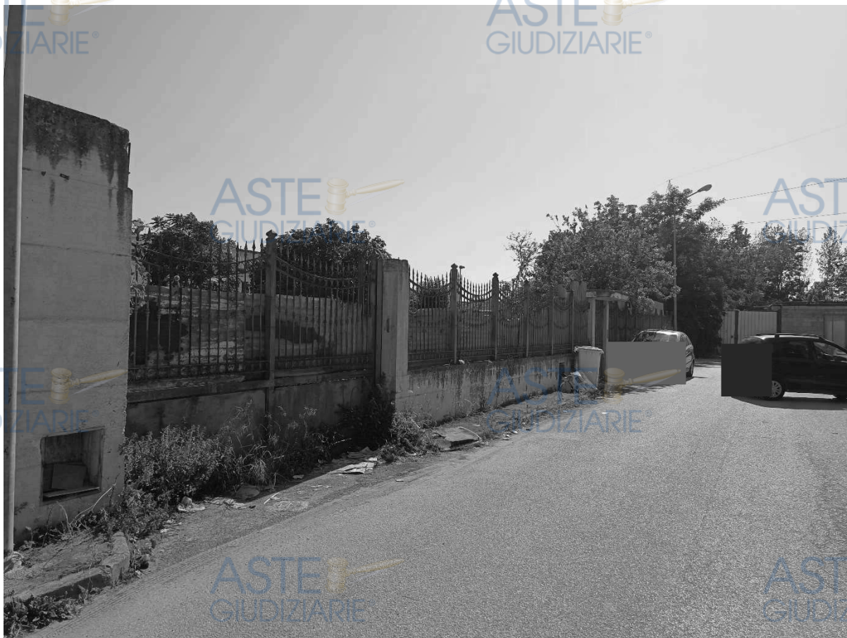
Foto 1. Esterno fabbricato, prospetto recinzione lotto
