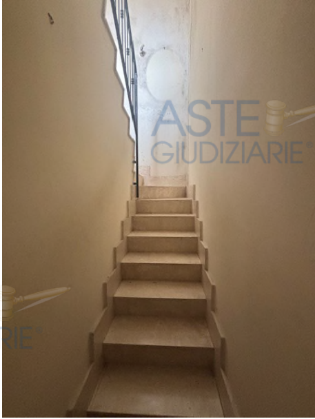
TRATTO DI SCALA CHE CONDUCE ALL'ULTIMO LIVELLO
