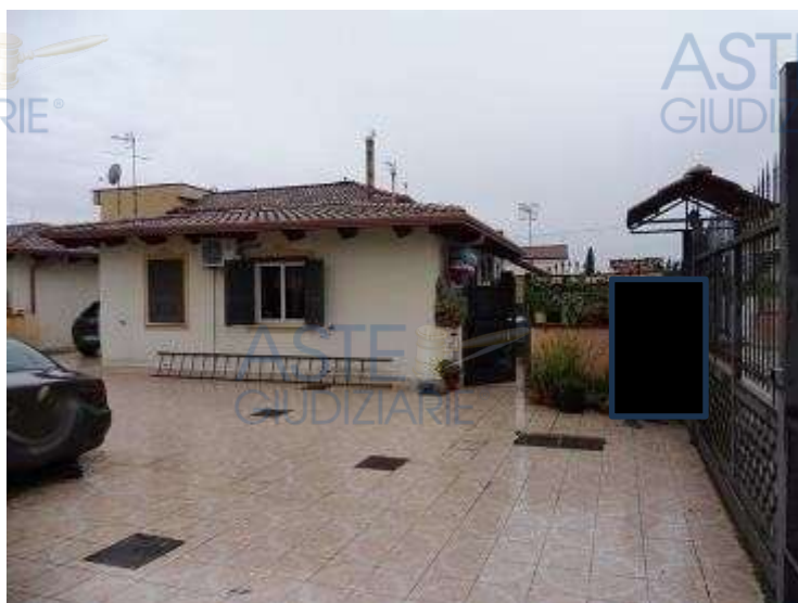
_immagini esterne – da cortile interno sub. 1 – B.C.N.C.
