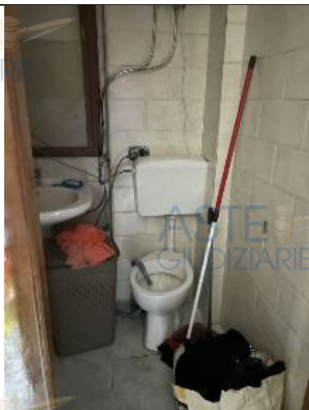
Vista w.c. piano terra
