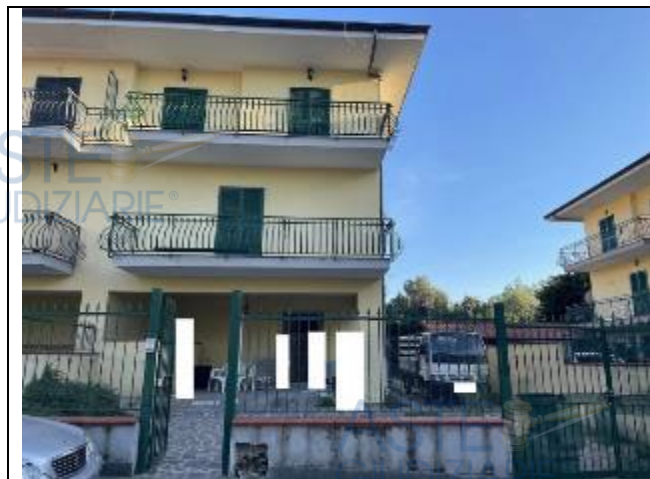
Vista dal cortile condominiale sub 1
