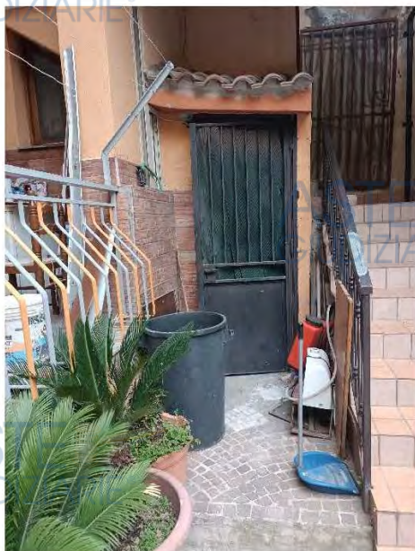
Foto 35. Vano accesso zona interrata
