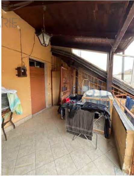
Foto 19. Terrazzo appartamento piano primo
