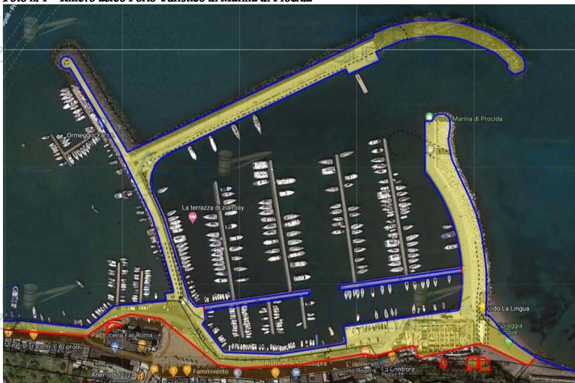
Foto n. 1 - Rilievo aereo Porto Turistico di Marina di Procida
