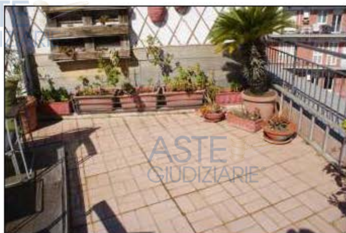
Terrazzo. Lungo le fughe delle mattonelle della pavimentazione si denotano marcati annerimenti e vegetazione.
