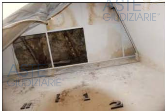
Stanza 2. Smontaggio del controsoffitto in tensotelo, sotto è visibile il sovrastante soffitto modulare.
