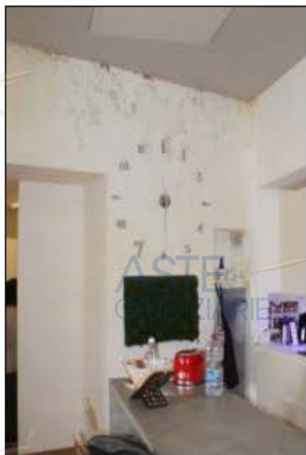
Stanza 2. Segni di eventi infiltrativi su parte della parete sud e nel vano di passaggio nella muratura
