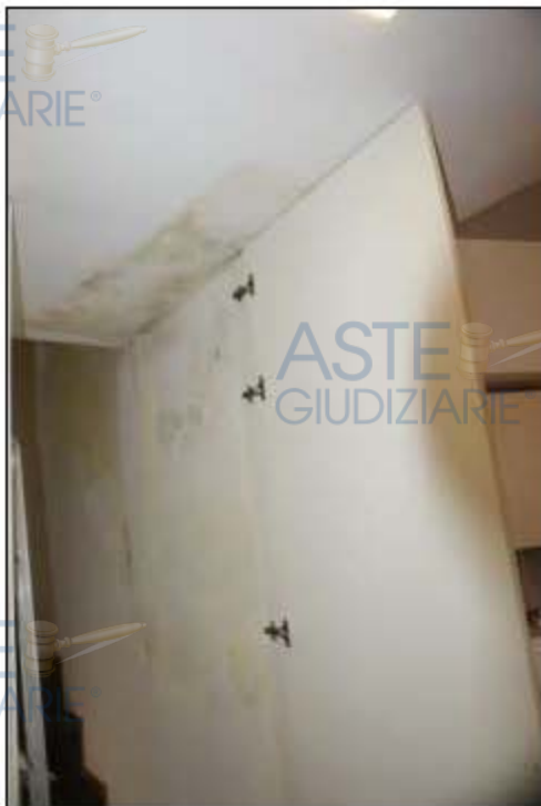
Vano scala interna. Lungo la parete a confine con la stanza 2 e all'intradosso del solaio segni di eventi infiltrativi.
