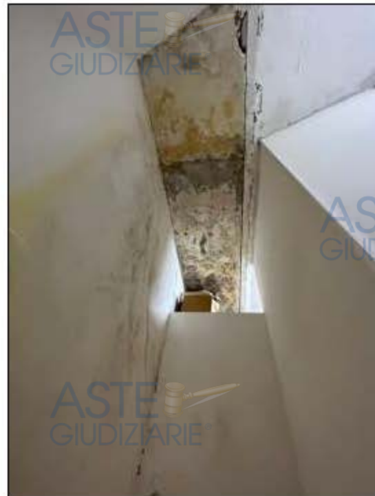
Vano scala interna. Lungo la parete a confine con la stanza 2 e all'intradosso del solaio segni di eventi infiltrativi.
