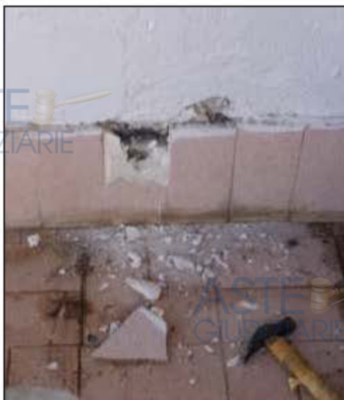
Manufatto sul Terrazzo. Saggio per verificare la presenza del risvolto del manto impermeabile.
