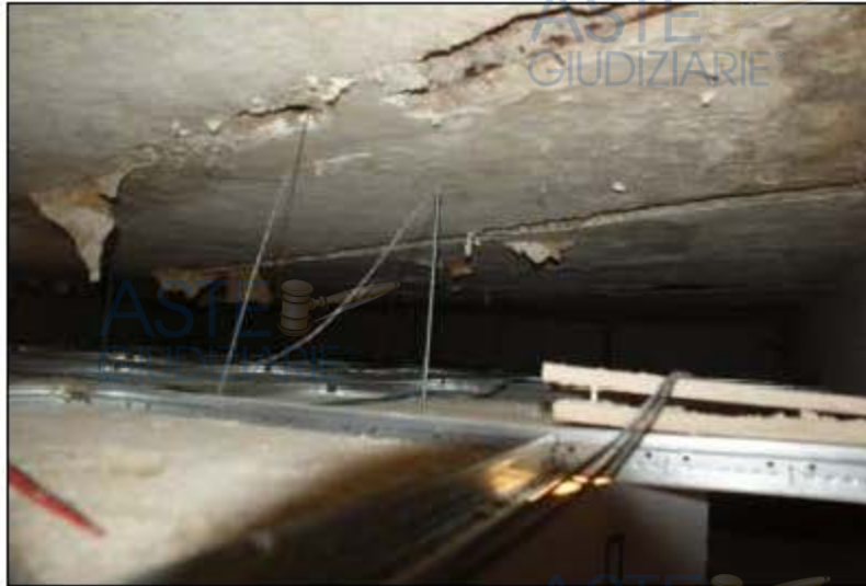
Stanza 2. L'intradosso del solaio, originariamente rivestito con carta da parato.
