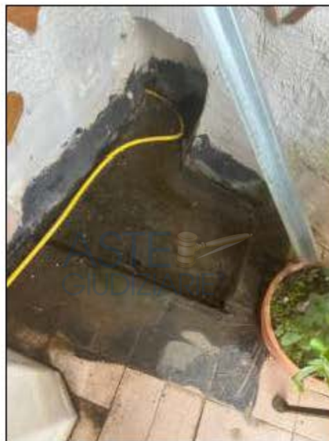
Terrazzo. Posizione dell'unico bocchettone di scarico e dettaglio del pozzetto.
