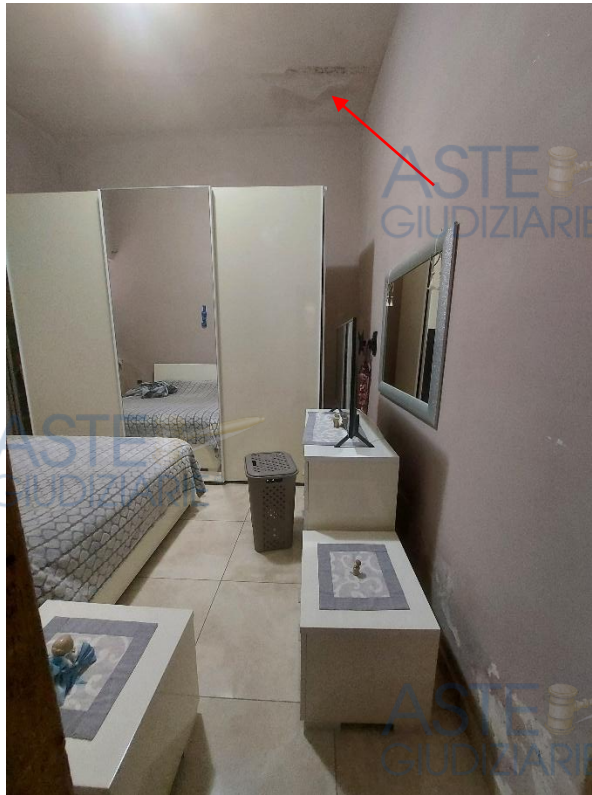
Locale L1 – tracce umidità intradosso solaio copertura
