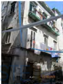
Fotografia 7 - Vista fabbricato da Via Giuseppe Piazzai.
