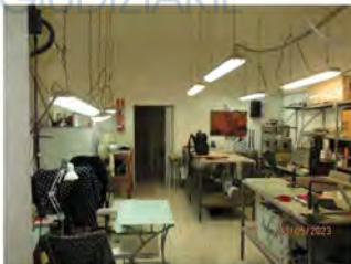
Fotografia 21 - Locale 3: La pavimentazione è costituita da piastrelle in ceramica smaltata; le pareti sono interamente rivestite con intonaci ordinari a finitura liscia e tinteggiate con pittura lavabile; il soffitto è costituito da una volta a "botte" ed è intonato e tinteggiato con pittura a tempera.
