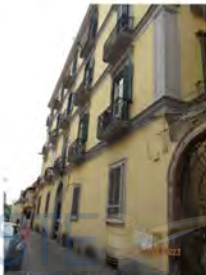
Fotografia 7 - Altra vista del fabbricato da Via Sant'Eramo Vecchio.
