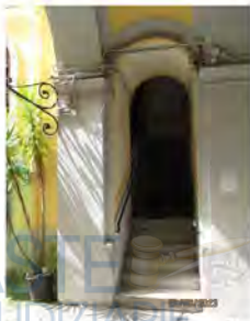
Fotografia 13 - La scala condominiale è accessibile dall'androne.
