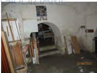
Fotografia 25 - Locale 3 : La pavimentazione è costituita da piastrelle in ceramica; le pareti sono rivestite con intonaci ordinari e tinteggiati con pittura lavabile; il soffitto è costituito da una volta a "vela", rivestito con intonaco grezzo non rifinito e tinteggiato con pittura a tempera.
