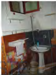
Fotografia 19 – Bagno è dotato di tazza igienica e lavabo; le pareti sono in parte rivestite con intonaci ordinari e tinteggiati con pittura lavabile, in parte risulta rivestite con piastrelle in ceramica. L'ambiente dispone di una finestra che affaccia nel "Locale 1".
