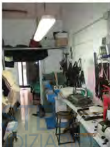
Fotografia 19 - Locale 2 le pareti sono rivestite con intonaci ordinari a finitura liscia e tinteggiate con pittura lavabile; il soffitto è costituito da una volta a "botte" ed è intonacato e tinteggiato con pittura a tempera.
