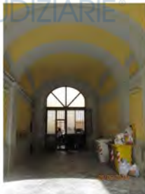
Fotografia 10 - Le pareti dell'androne sono rivestite con intonaci ordinari e tinteggiati con pittura al quarzo, adornate da cornici. Il soffitto è costituito da una volta a "botte" con arcate in sporgenza munite di cornici decorative.
