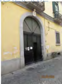
Fotografia 8 - All'interno del fabbricato vi si accede dal civico 16 di Via Sant'Eramo Vecchio, attraverso un ampio varco carrabile dotato di cancello in ferro a due ante e cancelli laterali.
