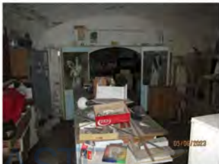
Fotografia 20 - Locale 2: è il primo dei due ambienti dell'immobile n. 3 (catastalmente Sub 8) della presente perizia, vi si accede dal "Locale 1" tramite un'arcata portante, comunica con il "Locale 3" ed occupa una superficie utile netta pari a mq. 31,68 ed ha una altezza utile interna massima dal piano di calpestio di ml. 2,90.
