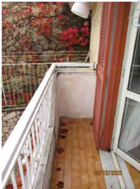
Fotografia 51 – Balcone : Risulta pavimentato per tutta la sua superficie da piastrelle in ceramica smaltata ed è protetto dall'esterno da un muretto rivestito da intonaci ordinari e tinteggiato con pittura al quarzo, sormontato da una ringhiera in ferro.
