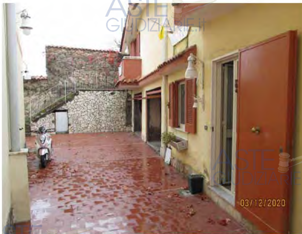
Fotografia 24 – Gli infissi esterni dell’appartamento sono costituiti da serramenti in ferro di tipo “persiane alla napoletana” con retrofinestre in alluminio e vetro camera, mentre il portoncino d’ingresso è dotato di portoncino blindato e di retroinfisso in alluminio e vetro camera; il locale deposito ed il locale box, sono invece dotati all’ingresso da
