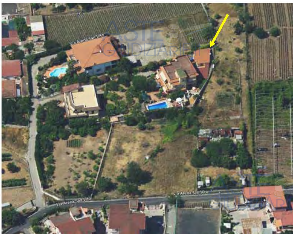
Fotografia 2 – Inquadramento territoriale lato Sud
