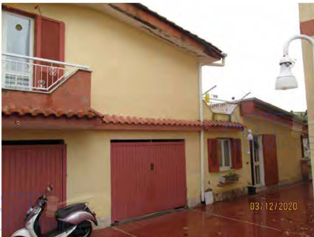
Fotografia 16 – Prospetto esterno libero esposto ad ovest.
