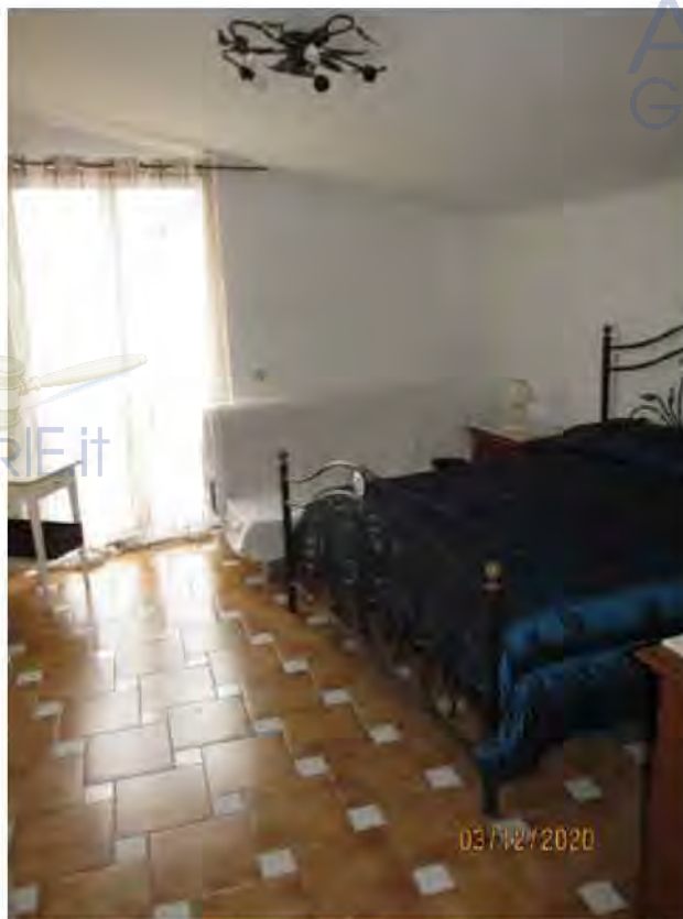
Fotografia 47 – Vano 2: La pavimentazione è costituita per tutta la superficie da piastrelle in ceramica smaltata; la parete nord, lungo il confine con il terrapieno, risulta controfoderata con elementi di pannellatura in cartongesso, in modo da creare un'intercapedine isolante, la restante parte invece delle pareti, sono rivestite da intonaci ordinari e tinteggiate con pittura lavabile; il soffitto del solaio è rivestito con intonaci ordinari e tinteggiato con pittura a tempera.
