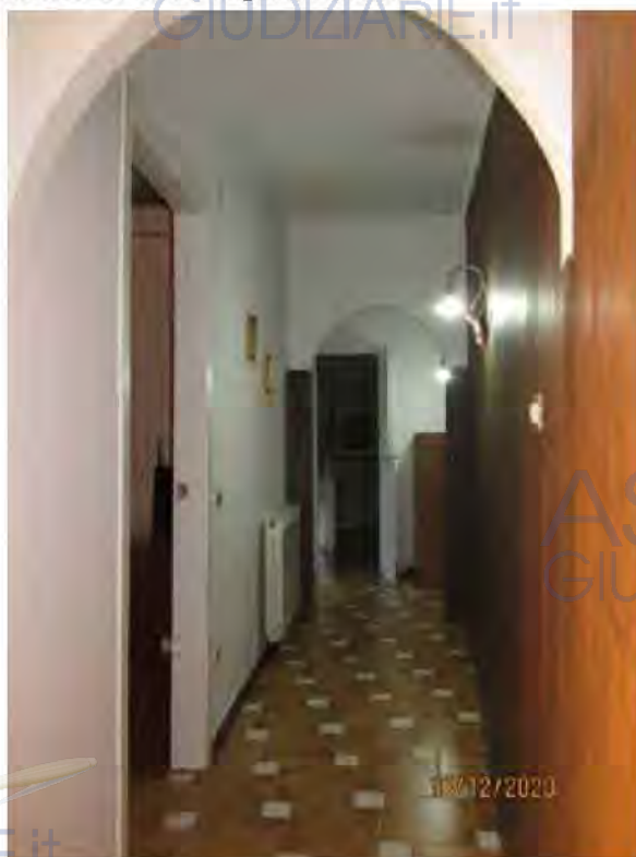
Fotografia 38 – Corridoio : Vi si accede dal "Soggiorno/Pranzo" del piano terra attraverso la "Scala interna", comunica con il "Vano 1", il "Vano 2" e il "Bagno 2", occupa una superficie pari a mq. 6,82 e un'altezza media dal piano di calpestio pari a m. 2,40.
