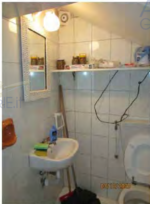
Fotografia 33 – Bagno 1: L'ambiente è dotato di tazza igienica e lavabo. La pavimentazione è costituita per tutta la sua superficie da piastrelle in ceramica smaltata, le pareti sono rivestite anch'esse per tutta la loro altezza con piastrelle di ceramica smaltata.
