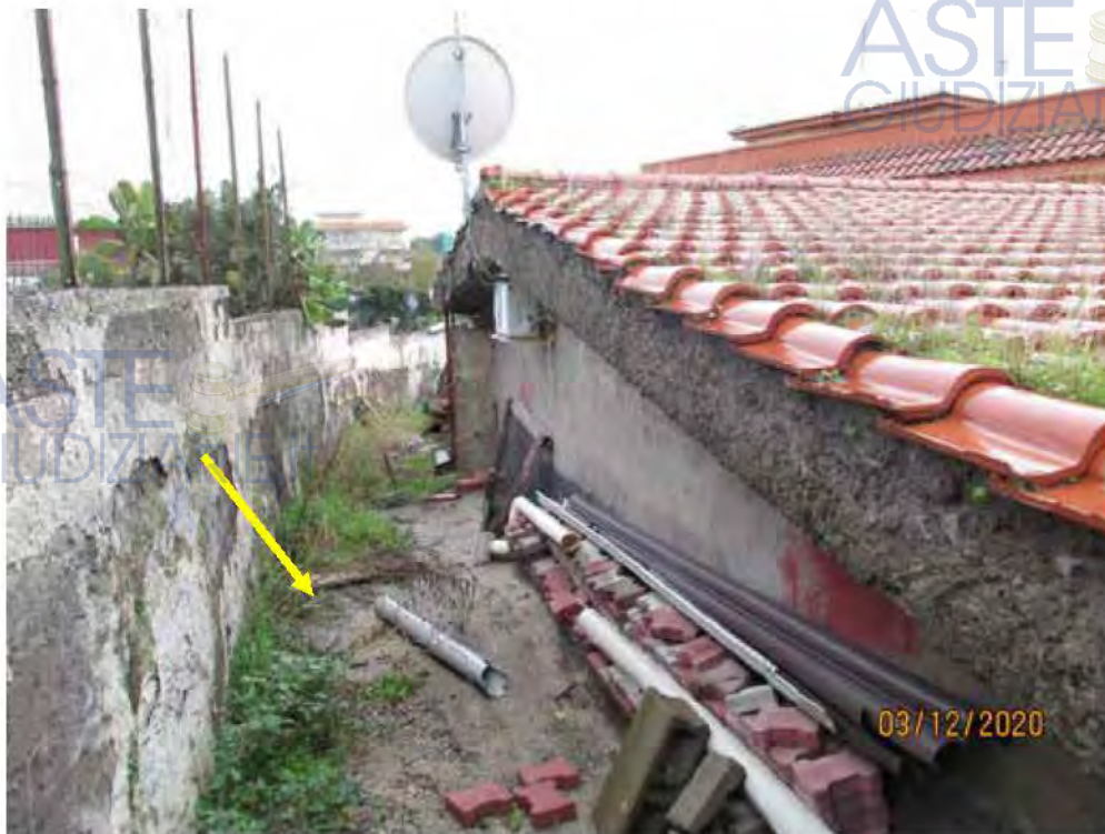
Fotografia 19 – Terrapieno addossato al prospetto est dell'edificio pignorato.
