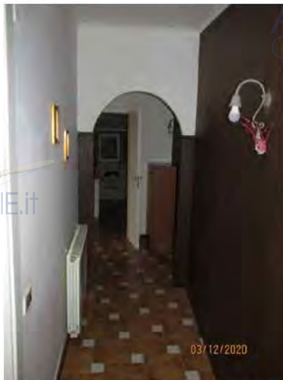
Fotografia 39 – Corridoio: La pavimentazione è costituita per tutta la superficie da piastrelle in ceramica smaltata; la parete, lungo il confine con il terrapieno, è rivestite con doghe in legno, in modo da creare una sorta di intercapedine isolante, la restante parte invece delle pareti sono rivestite da intonaci ordinari e tinteggiate con pittura lavabile; il soffitto del solaio risulta rivestito da intonaci ordinari e tinteggiatura con pittura a tempera.
