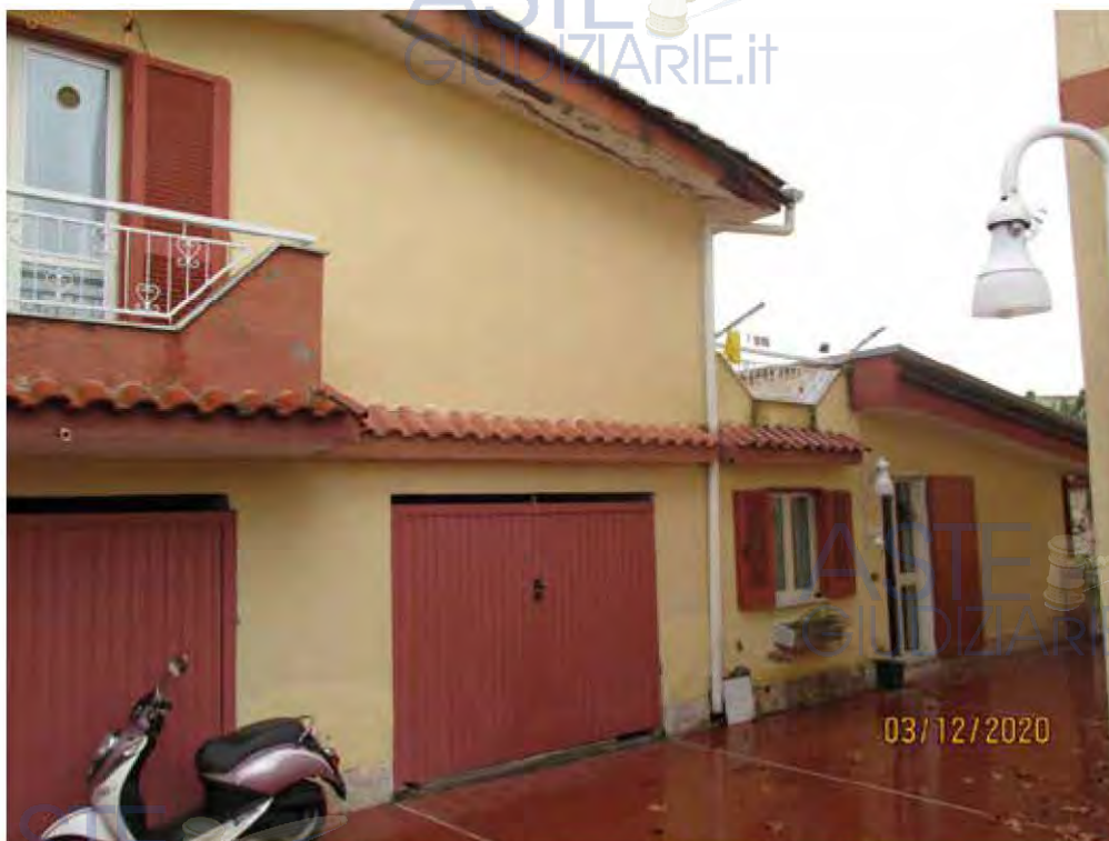
Fotografia 16 – Prospetto esterno libero esposto ad ovest.
