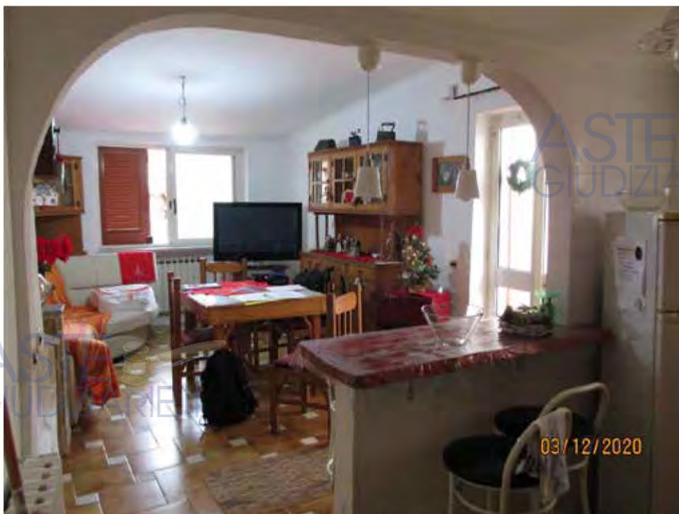
Fotografia 27 – Soggiorno/Pranzo: La pavimentazione dell'intero ambiente è costituita da piastrelle in ceramica smaltata; le pareti sono rivestite con intonaci ordinari e tinteggiate con pittura lavabile; il soffitto del solaio è rivestito da intonaci ordinari e tinteggiato con pittura a tempera.
