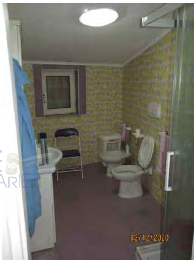
Fotografia 53 – Bagno 2 : La pavimentazione è costituita per l'intera superficie da piastrelle in ceramica smaltata; le pareti sono anch'esse rivestite da piastrelle in ceramica smaltata; il soffitto del solaio è rivestito da intonaci ordinari e tinteggiati con pittura a tempera.
