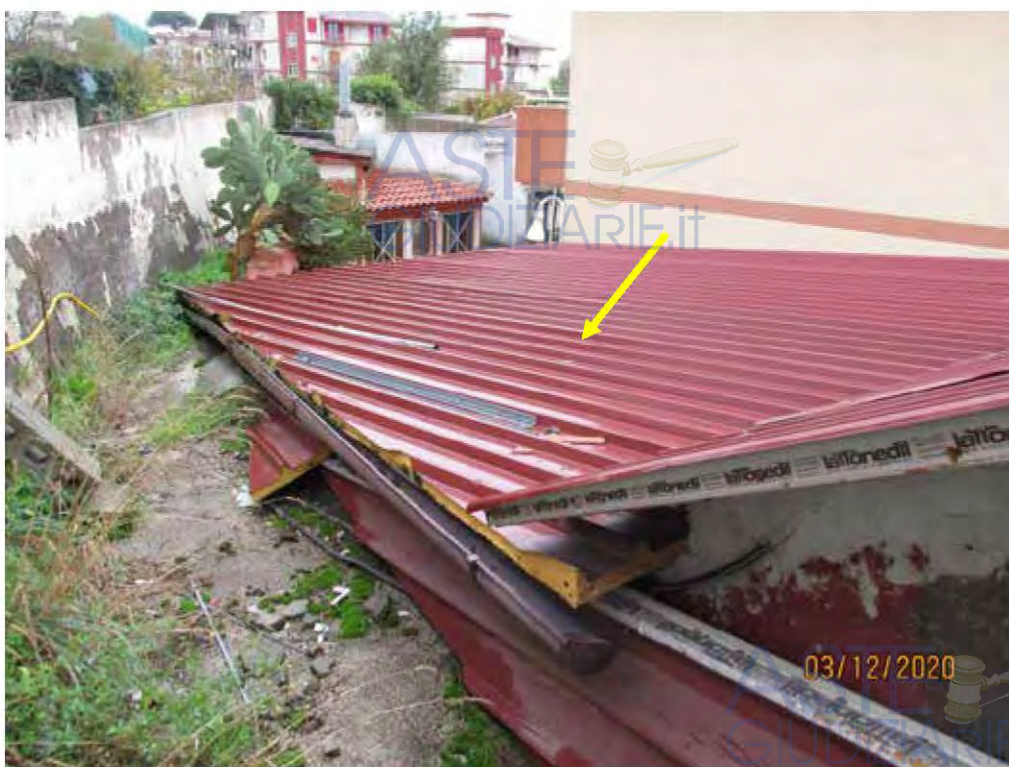
Fotografia 22 – La parte di fabbricato che si eleva per un solo livello fuori terra presenta invece un solaio di copertura ad una sola falda inclinata rivestito da una struttura di pannelli coibentati in lamiera metalliche grecate coibentati.
