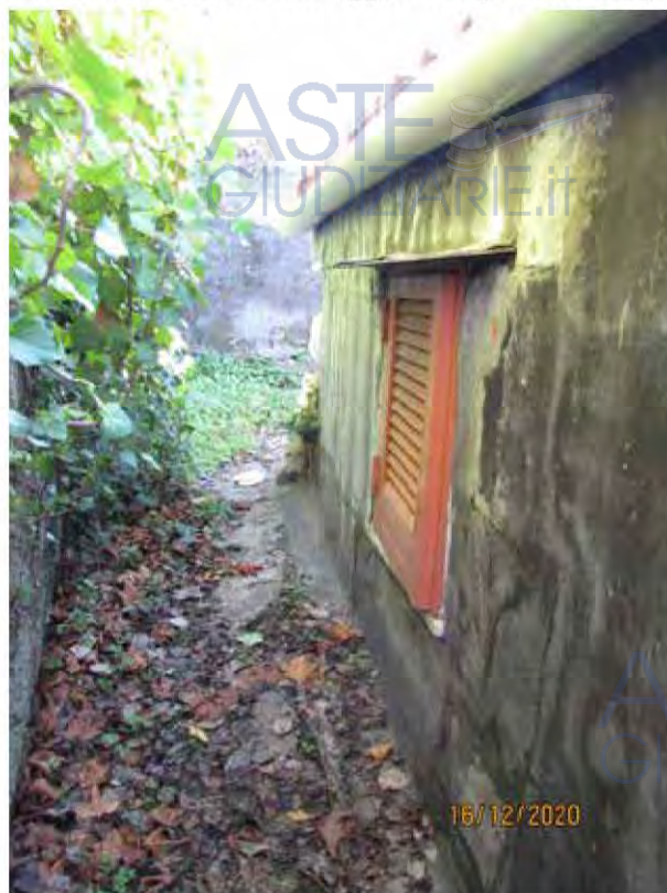
Fotografia 54 – Bagno 2 : Il bagno, lungo la parete nord, è dotato di finestra dotata di infisso in alluminio con vetro camera protetto all'esterno da un infisso in ferro di tipo “persiana alla napoletana”.
