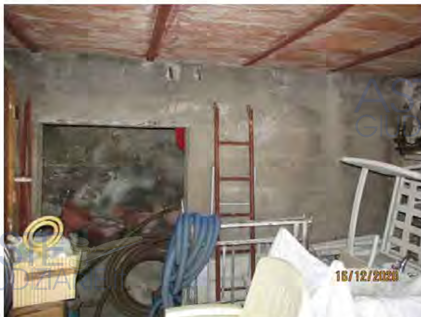
Fotografia 60 – Deposito: le pareti sono rifinite con intonaci ordinari a finitura rustica; il soffitto del solaio si presenta allo stato grezzo con l'orditura del solaio a vista. Il locale è privo di un impianto elettrico.
