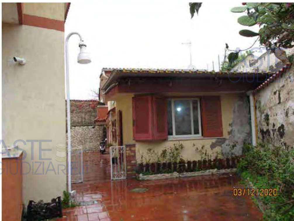
Fotografia 17 – Prospetto esterno libero esposto a sud.
