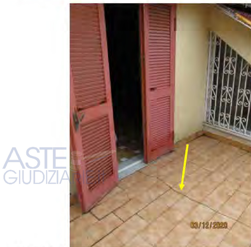
Fotografia 45 – Terrazzino: Sulla pavimentazione sono presenti alcuni segni di lesione, che però non destano preoccupazione e/o segni di cedimento strutturale, probabilmente sono dovute alla vetustà del pavimento e alla scarsa resistenza alle sollecitazioni di dilatazione termica, a cui la piastrella è sottoposto nel periodo sia invernale sia estivo.
