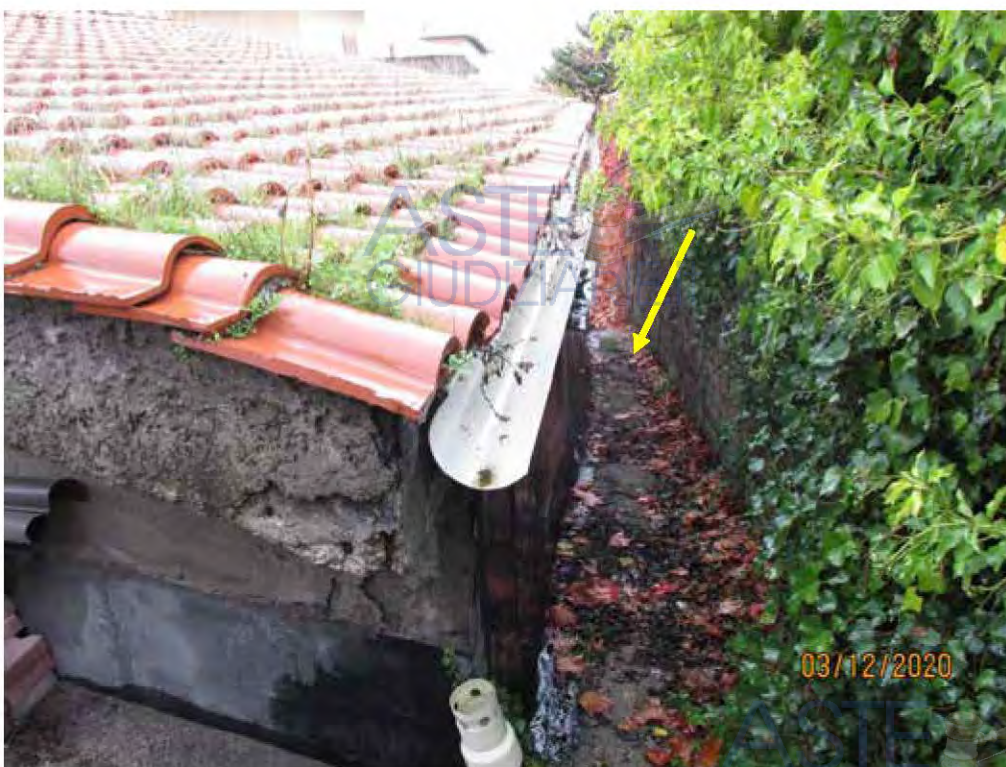
Fotografia 18 – Terrapieno addossato al prospetto nord dell'edificio pignorato.
