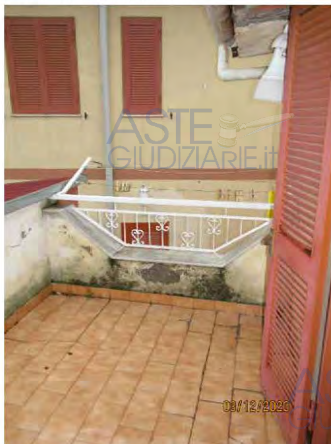
Fotografia 44 – Terrazzino: Lungo il perimetro è presente un muretto di protezione rivestito da intonaci ordinari e tinteggiato con pittura al quarzo, sormontato da una ringhiera in ferro. Ad ovest affaccia sul cortile comune e a sud affaccia sul solaio di copertura del “Soggiorno/Pranzo”, mentre ad est è delimitato dal vano finestra che immette nel vano della “Scala interna”.
