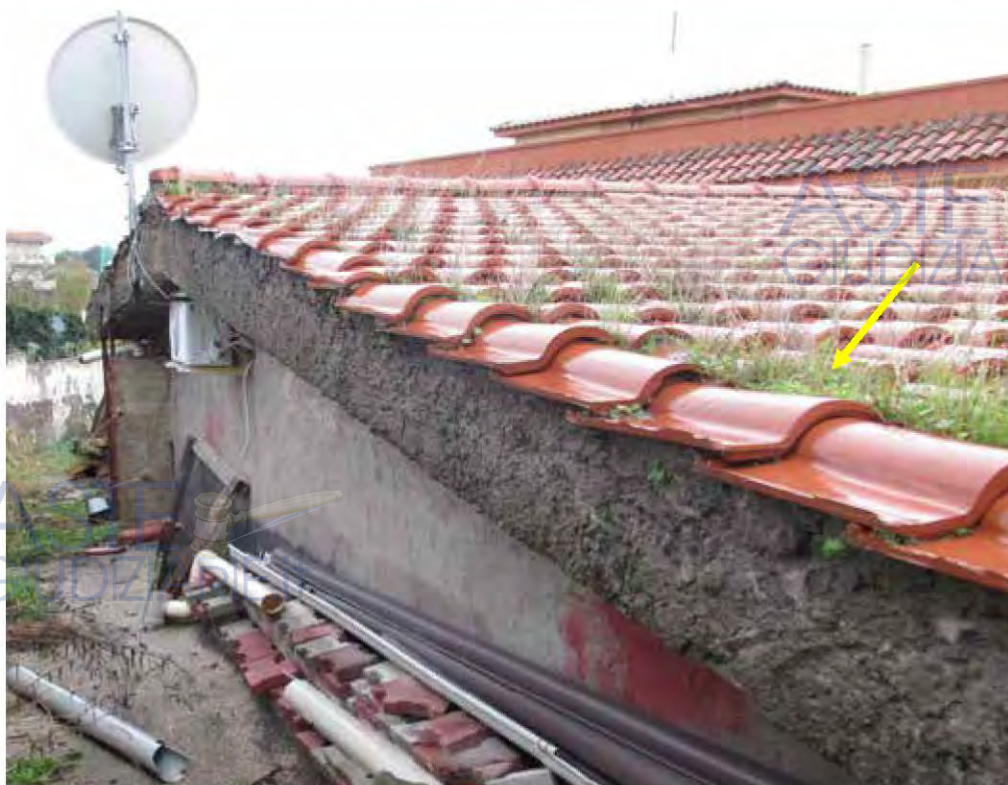
Fotografia 21 – La parte di fabbricato che si eleva per due livelli fuori terra presenta il solaio di copertura a due falde inclinate interamente rivestite da tegole portoghesi.
