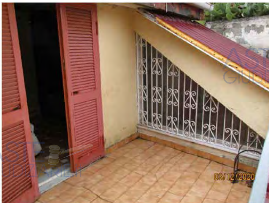
Fotografia 43 – Terrazzino: Vi si accede dal “Vano 1”, occupa una superficie utile netta pari a mq. 8,02 e risulta quasi interamente scoperto. La pavimentazione è costituita per tutta la superficie da piastrelle in ceramica smaltata per esterni.
