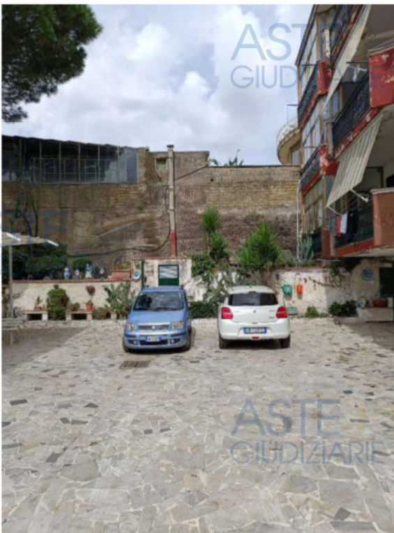
Area antistante il fabbricato ad uso comune
