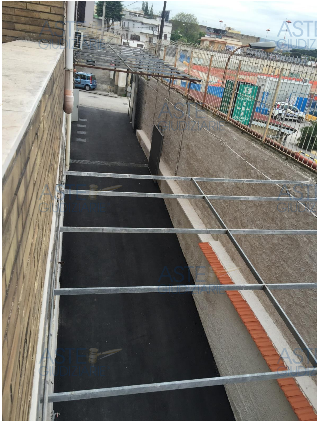
Foto n. 5 – rampa di ingresso al piano interrato
