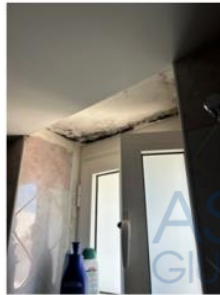
Foto 24 - Bagno - particolari dei segni di muffa
