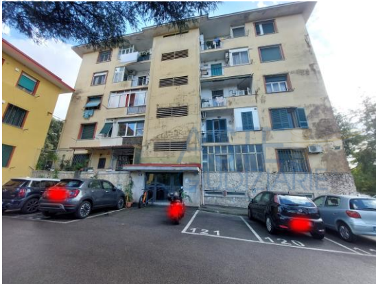
ingresso palazzina Q
