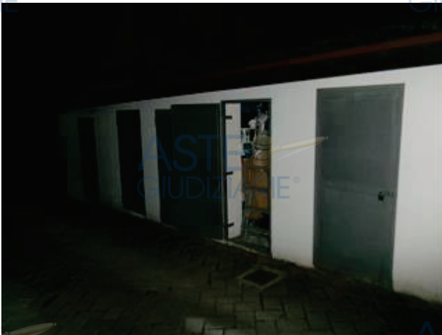
ingresso del deposito di pertinenza
