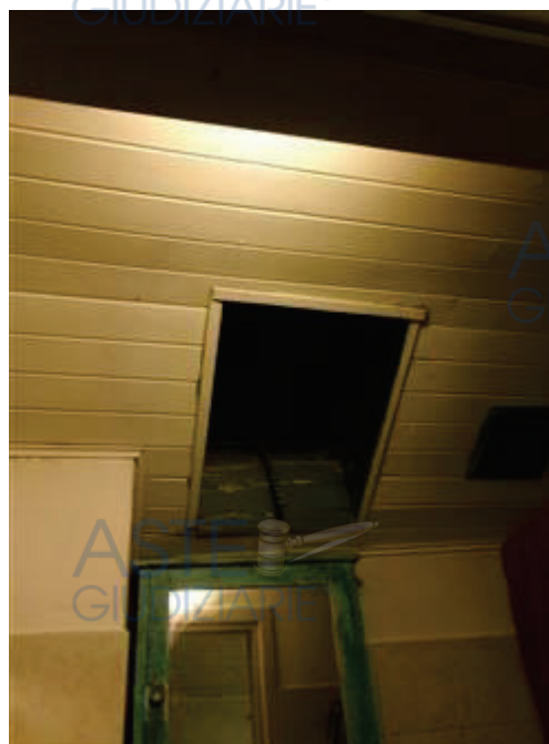
finestra tipo "velux" locale bagno
