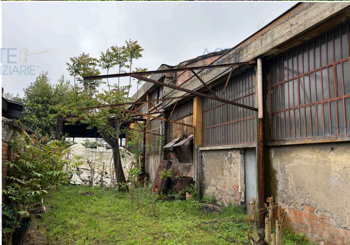
Fig.2-Ripresa fotografica del cumulo posto all'esterno del capannone
