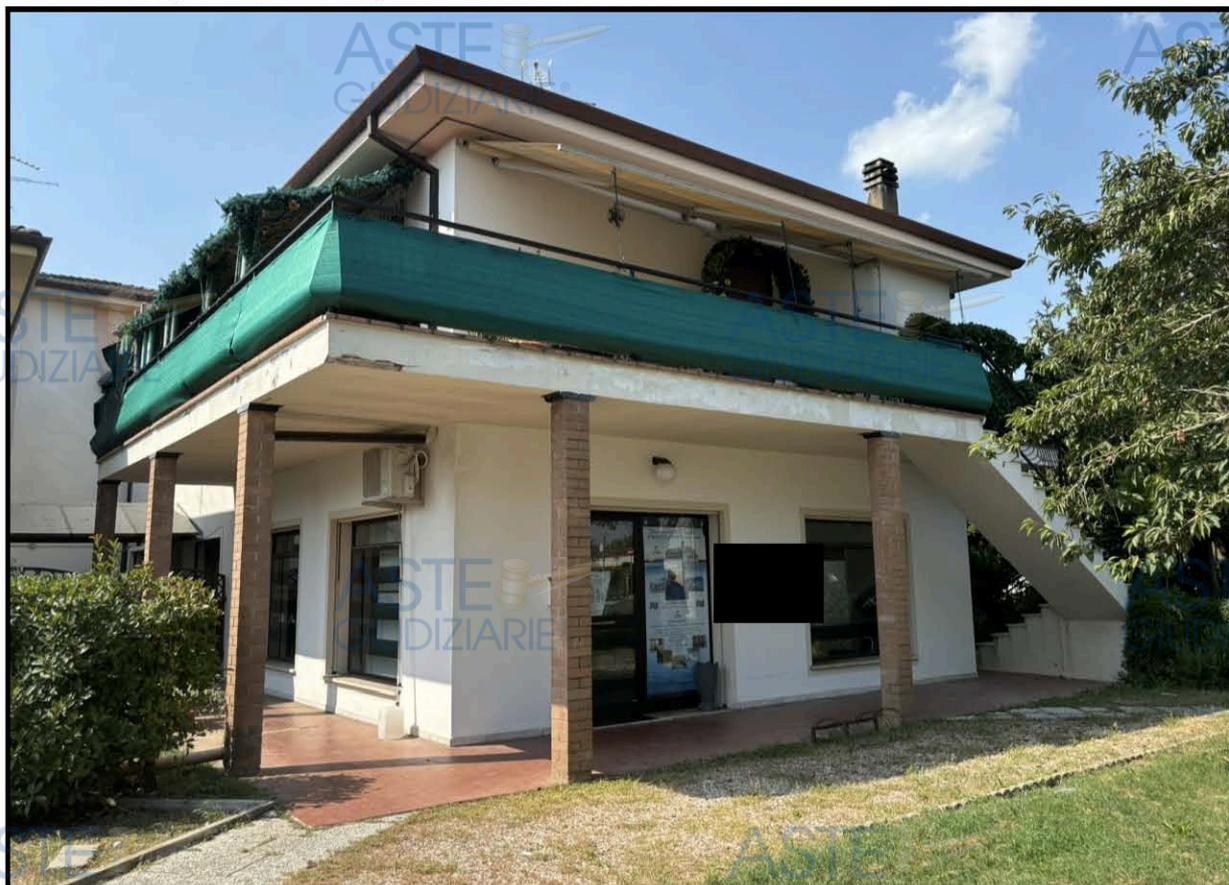
La struttura dell'immobile è caratterizzata da travi e pilastri in c.a.p. con murature di tamponamento in laterizio intonacate ambo i lati, solai interpiano e di copertura di tipo tradizionale in latero cemento e sovrastante finitura in tegole di cotto. L'unità commerciale risulta inserita in contesto condominiale e risulta ubicato al piano terra nella parte a Sud est.
