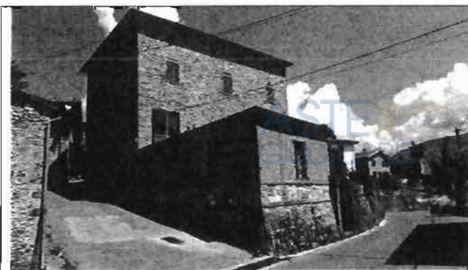
Vista da Strada provinciale angolo via Savoreta
