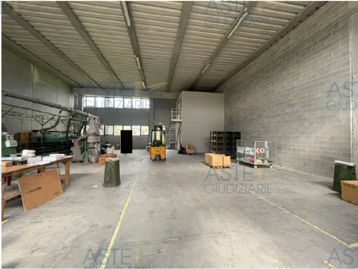
Foto 5 – Vista interna verso la facciata posteriore – Sulla destra blocco servizi e ufficio
