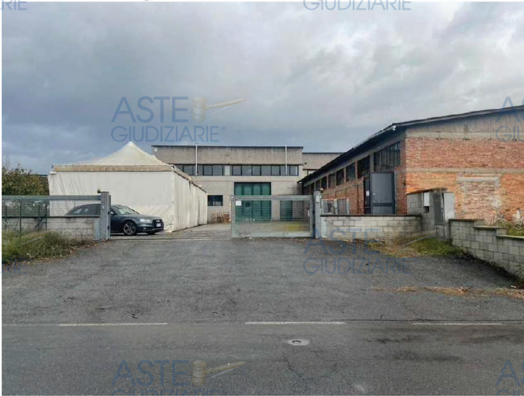
Foto 1 – Vista di insieme dalla Via Poggio Baldino
