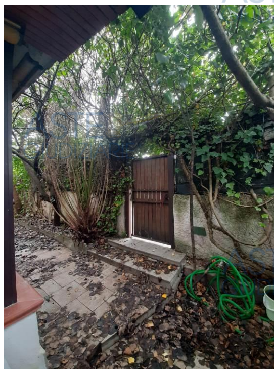
Cancelletto pedonale accesso alla corte
