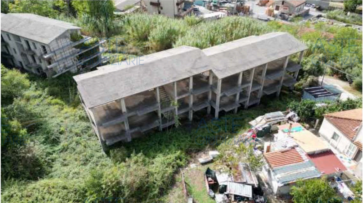
Fig. 3. Foto aerea Corpo A (sopralluogo 23/10/2023)
