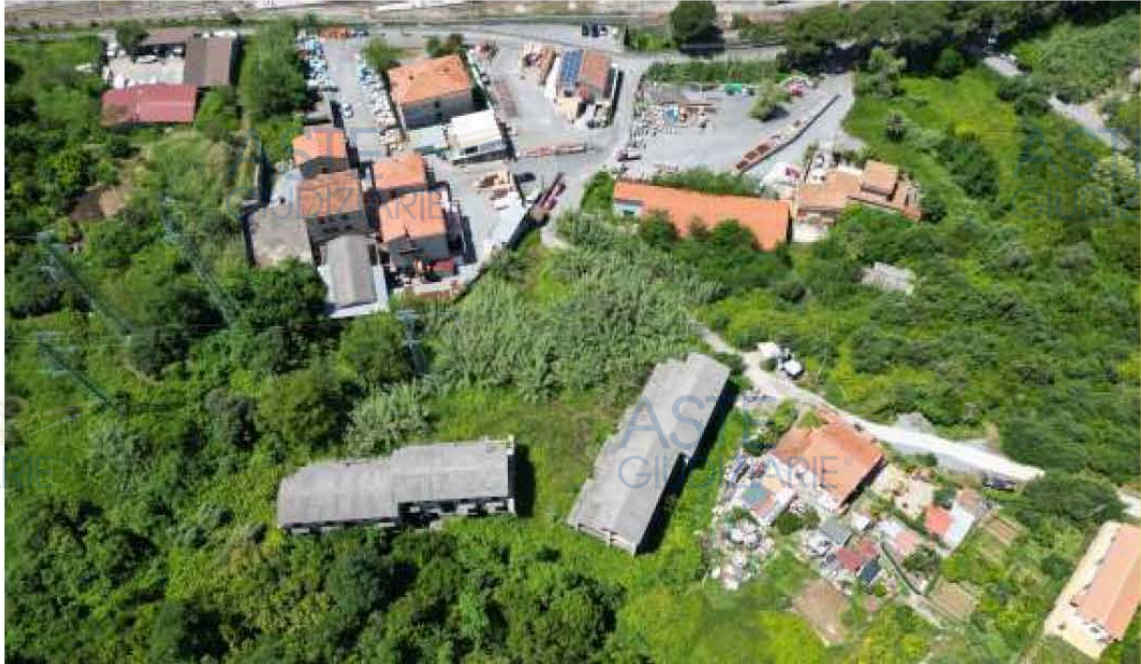
Fig. 1.Foto aerea immobili siti in Maratea (Pz) loc. Profiti. (sopralluogo 23/10/2023)
