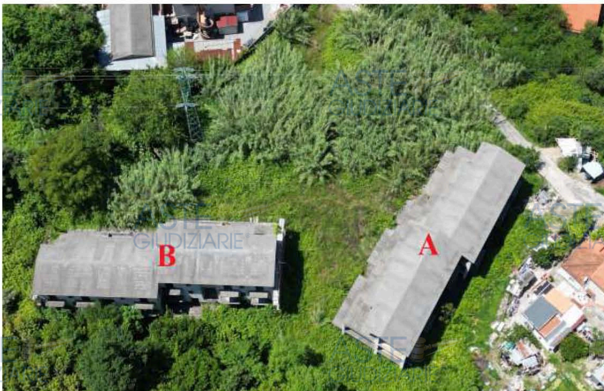
Fig. 5. Foto aerea con indicazione dei due manufatti.
