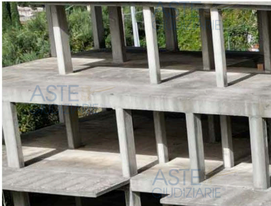
Fig. 7. Foto interna Fabbricato A. (particella 2653)
