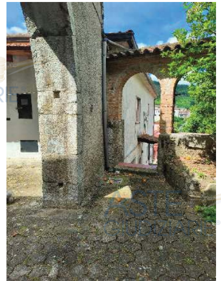
Figura 12: vista scala accesso laterali da corte comune
