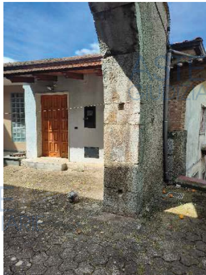
Figura 11: vista ingresso da corte comune
