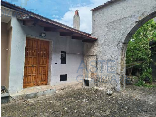
Figura 13: Particolare ingresso abitazione
