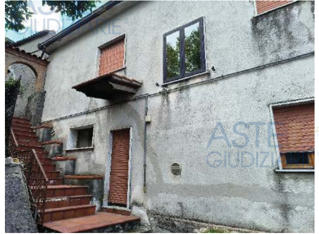
Figura 14: vista esterna da piano seminterrato
