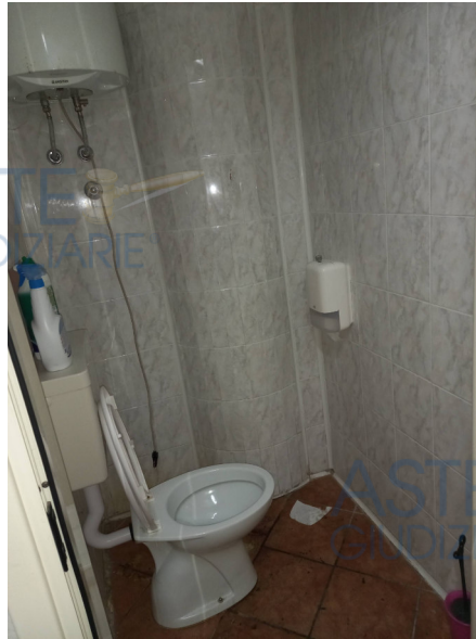
Foto 54: WC Uffici Piano Secondo
