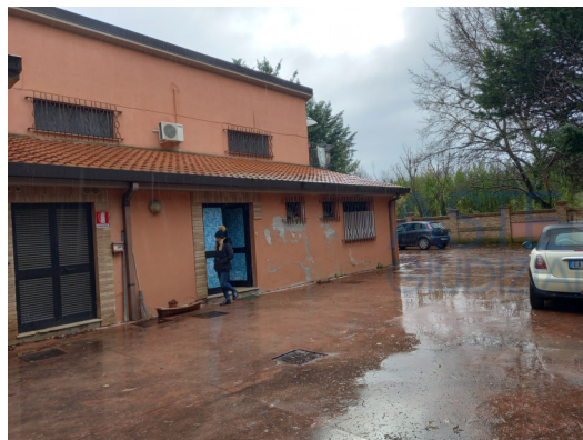
Foto 6: Ingresso abitazione-Piano Terra
