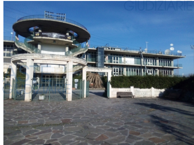
Foto 61: Sala Scommesse (PT) ed Uffici (P. 1 e 2)
