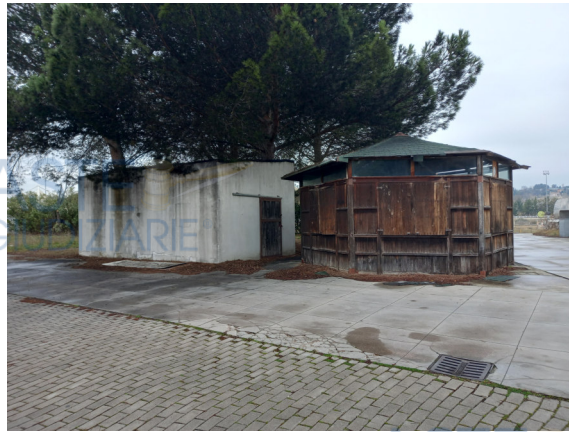
Foto 51: Fabbricato 4 - Magazzino e Deposito
