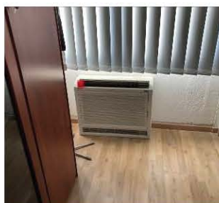
Unità ventilante interna
