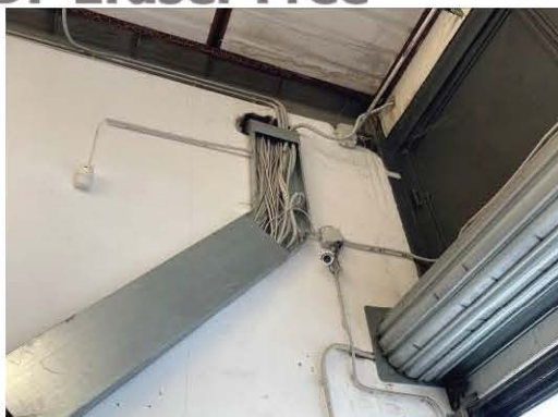
Partenza impianto elettrico
