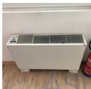
Unità ventilante interna
