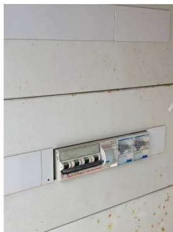
Differenziale magnetotermico + 2 diff. puri
