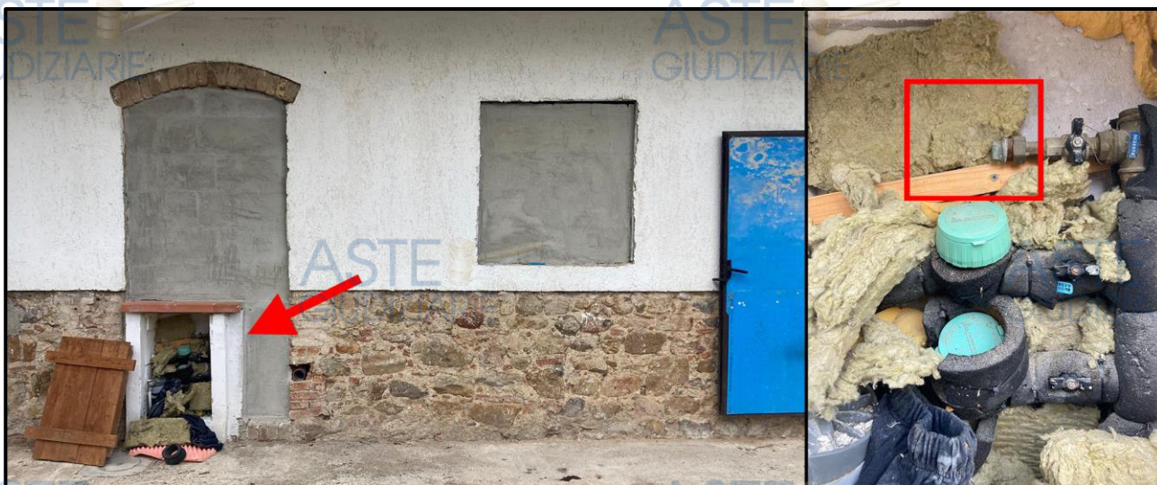
Impianto idrico: punto di fornitura e alloggiamento contatori
