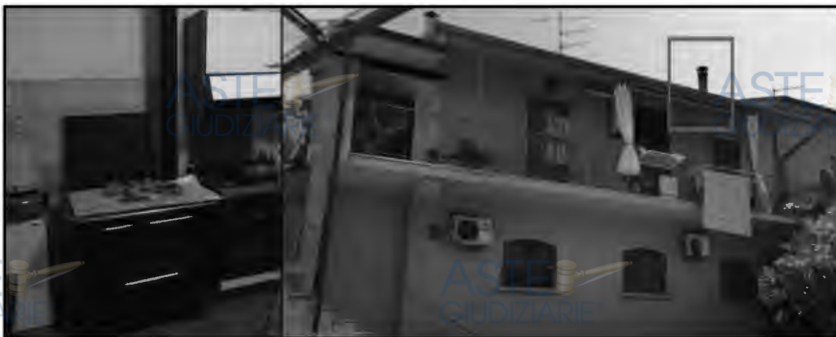
Termocucina e scarico fumi
