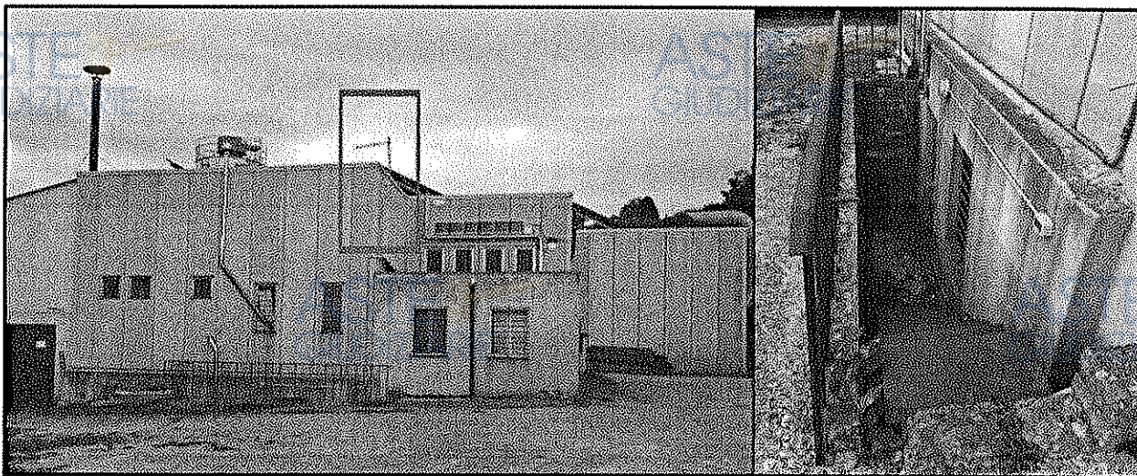
Antenna su copertura e scala per raggiungere gli ambienti abitativi
