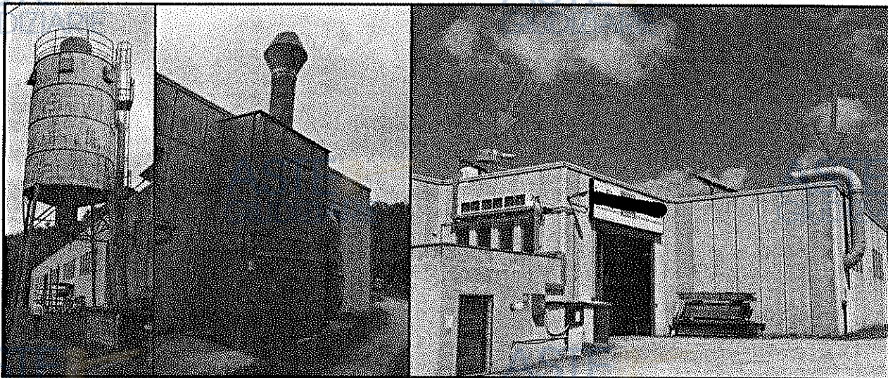
Silos per residui legnosi, silos per polveri fini, areazione vano principale, ventilazione vano verniciatura
