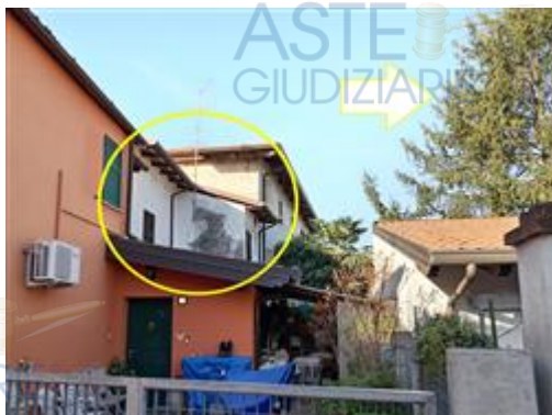
Facciata a Nord-Est
