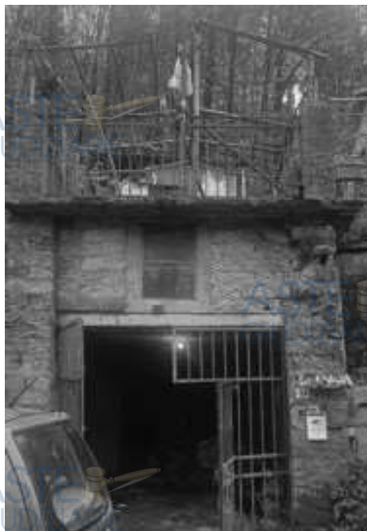
immagine 15: manufatto ad uso box/deposito
