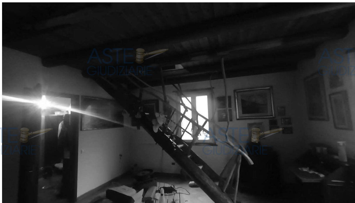
immagine 9: solaio sottotetto e scala di accesso
