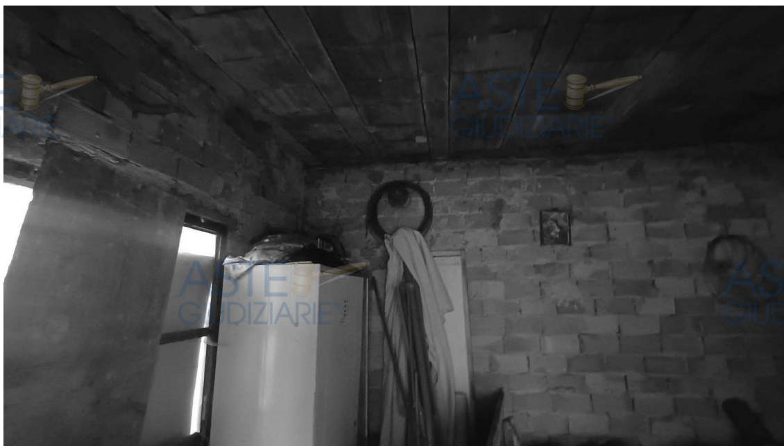
immagine 14: manufatto ad uso cantine (interno)
