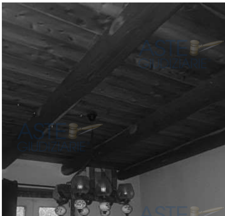
immagine 10: solaio sottotetto
