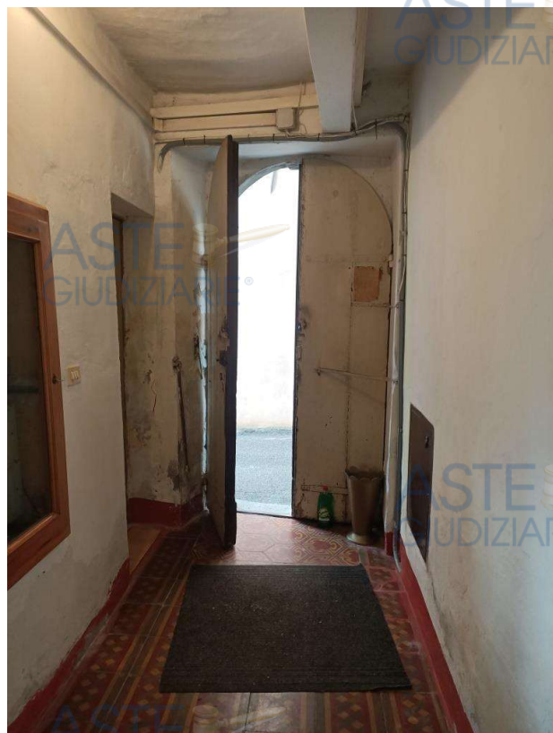
INGRESSO COMUNE PIANO TERRA CON VISTA PORTONE DI INGRESSO VIA GIUSEPPE GARIBALDI n.21 E PARTICOLARE CONTATORI NELL'INGRESSO COMUNE PIANO TERRA
