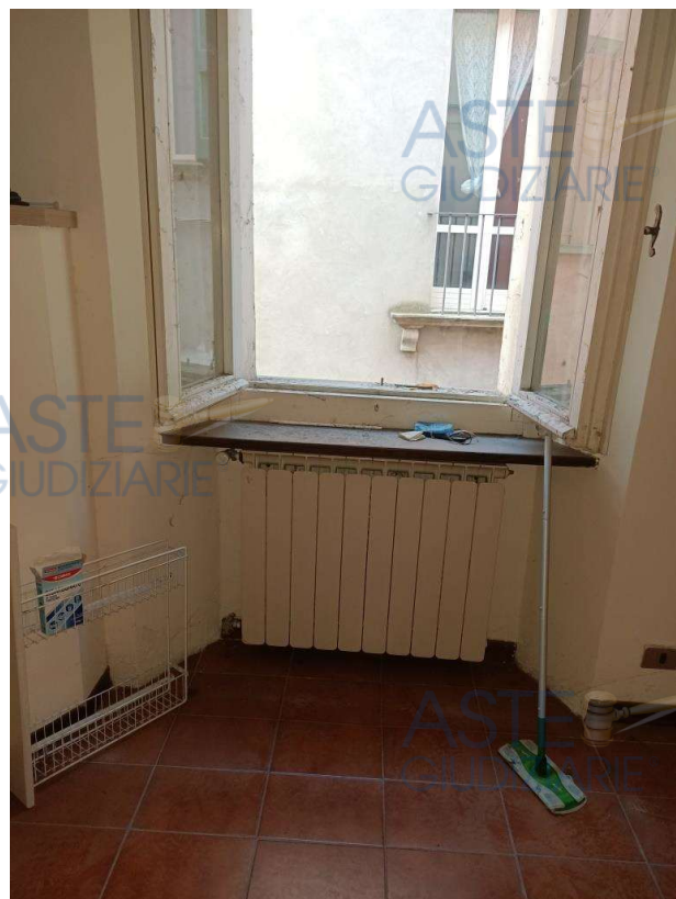
PARTICOLARE INFISSI E RADIATORI
